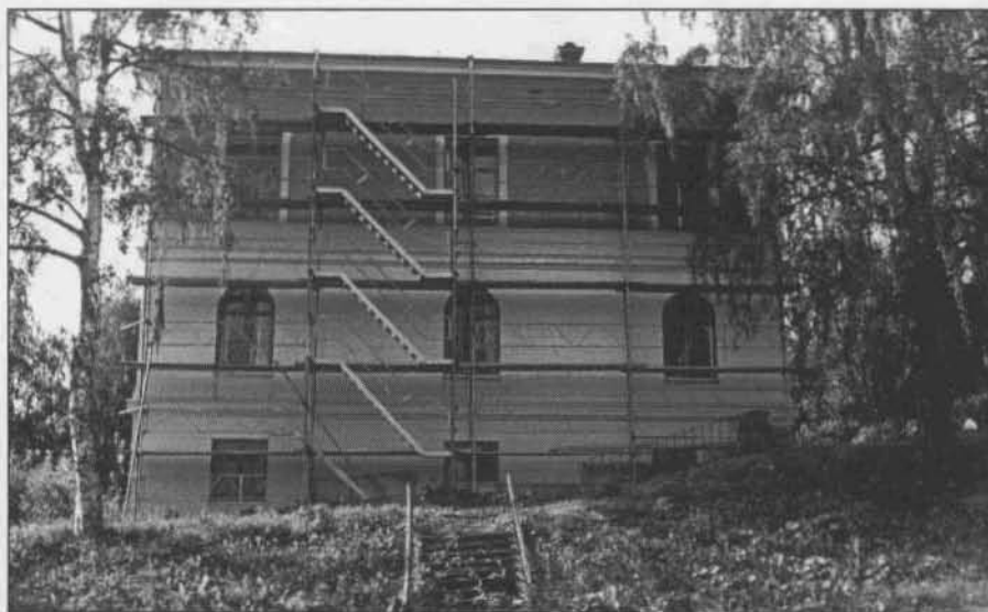
Fasaden efter restaurering
