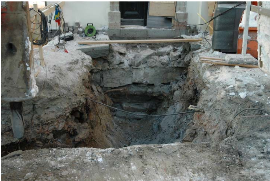
Schakt 4. Foto från öst.
