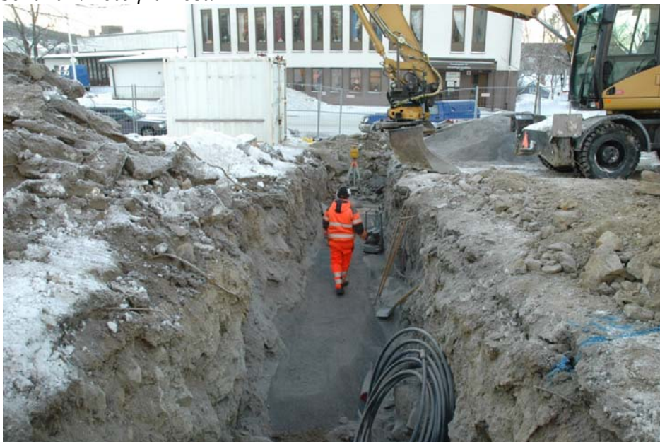
Schakt 4. Foto från norr.
