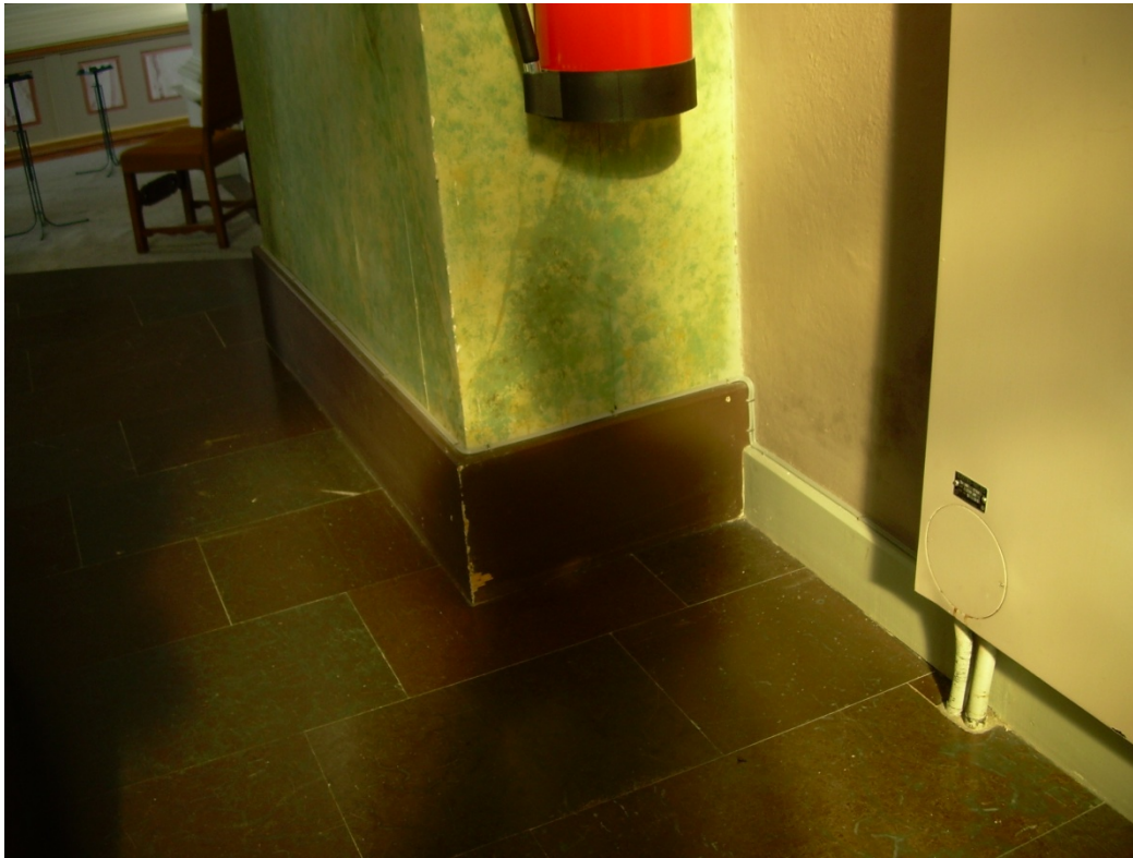
Före ombyggnaden släta element och golvlister kring pelarnas fundament.
