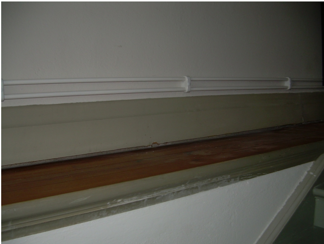
Ledningar till element på orgelläktaren.
