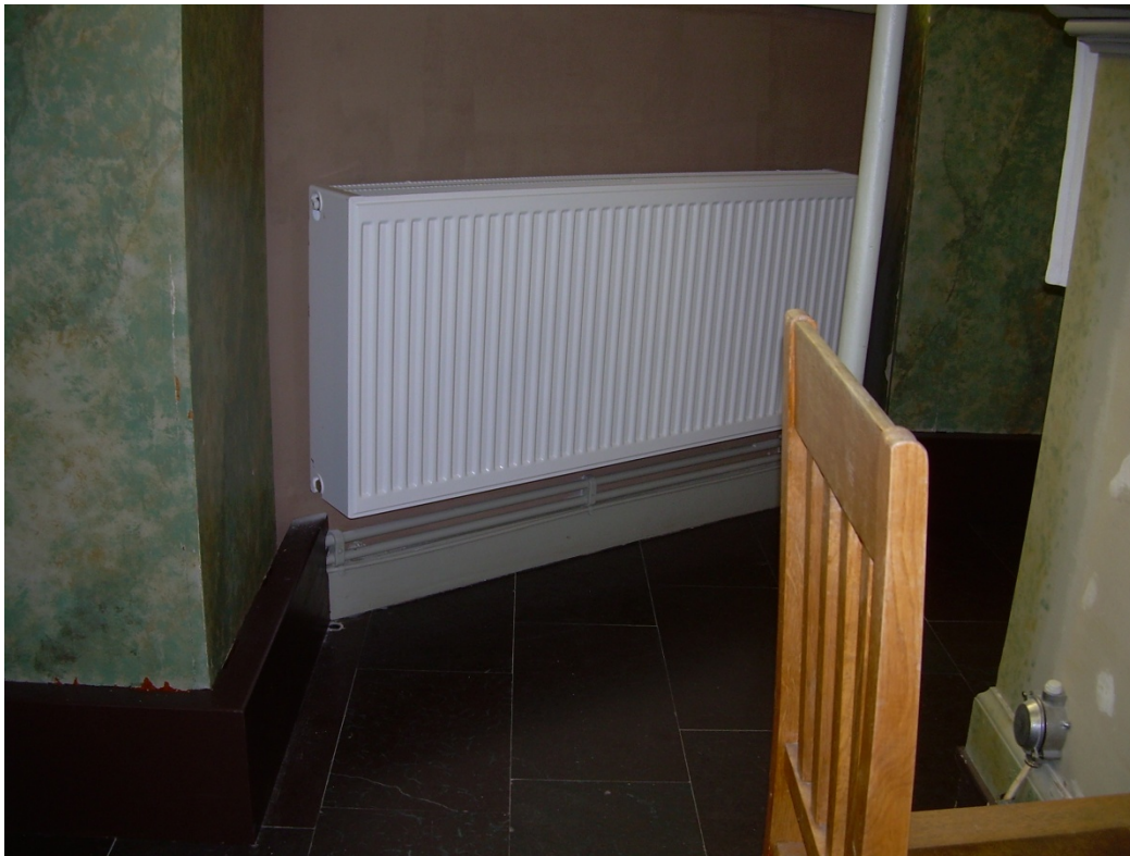
Nytt element med ledningar och ny golvlister.
