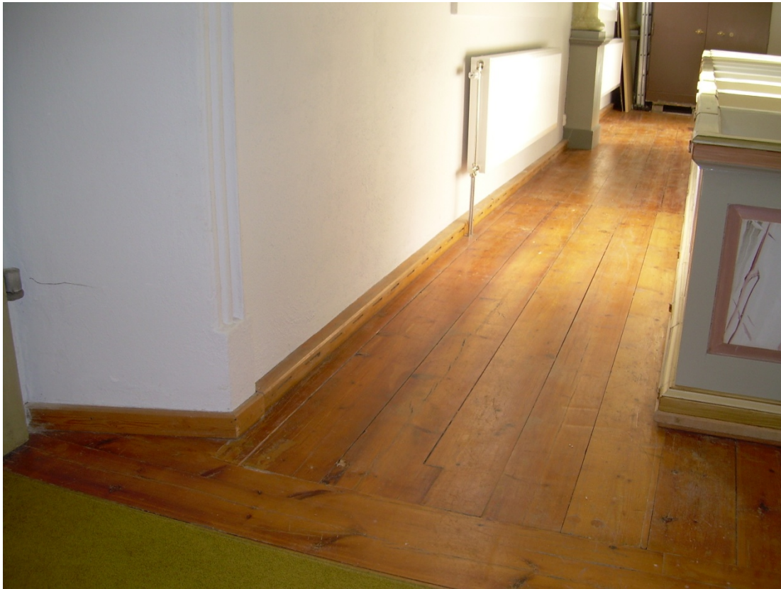
Låg golvlist i bakre delen av kyrkorummet.
