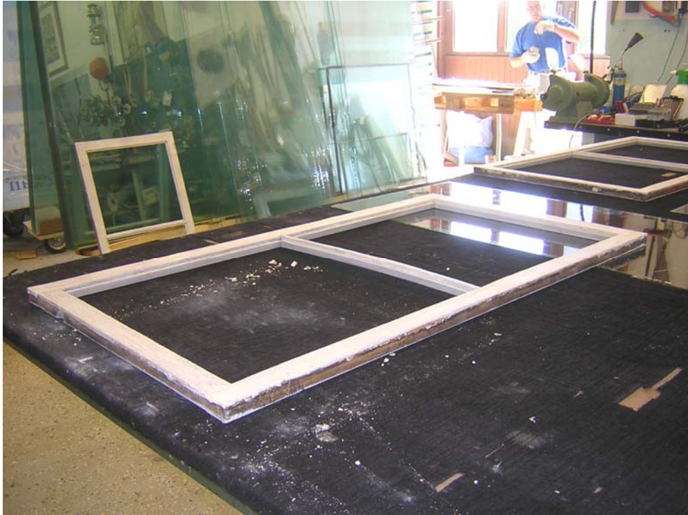
2006-06-30. Grundmålad ytterbåge på verkstad före kittning.
