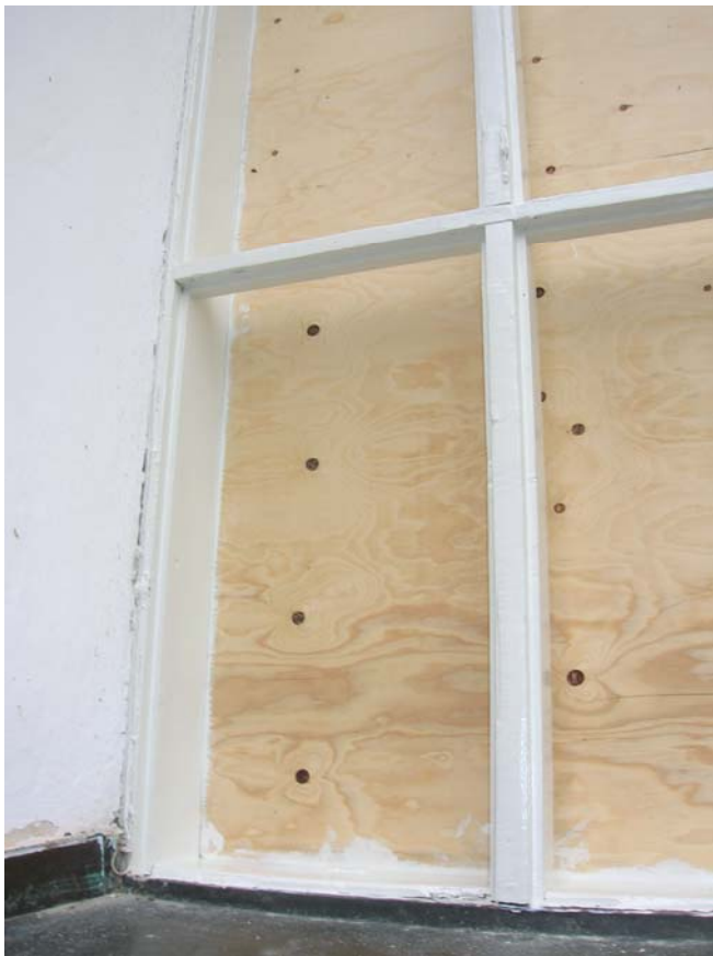
2006-07-03. Restaurerade karmar och spröjs, norra fasaden.
