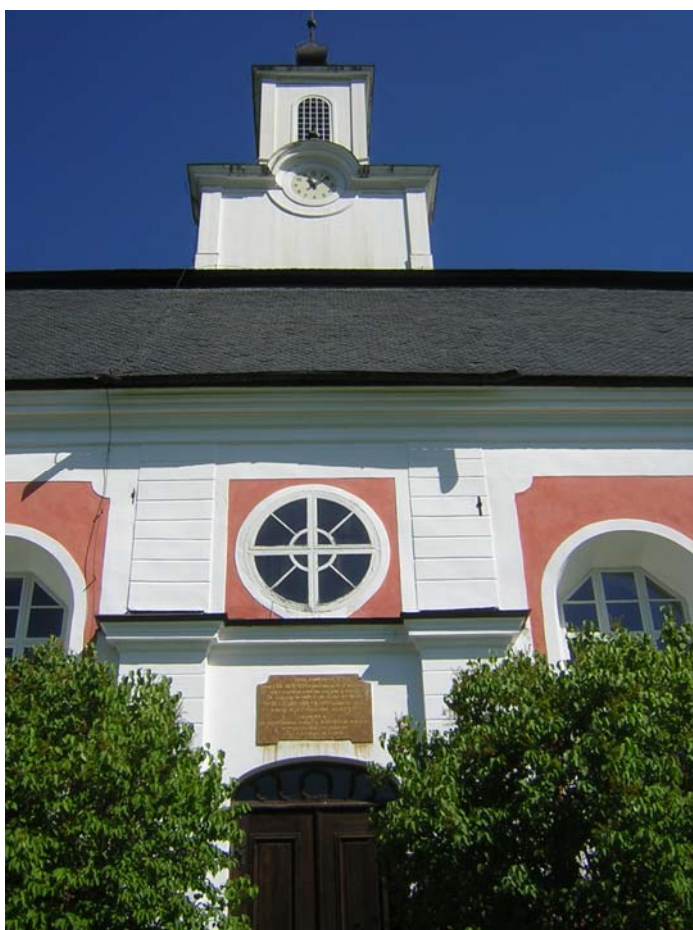
2006-06-30. Södra fasadens fönster före restaurering.
