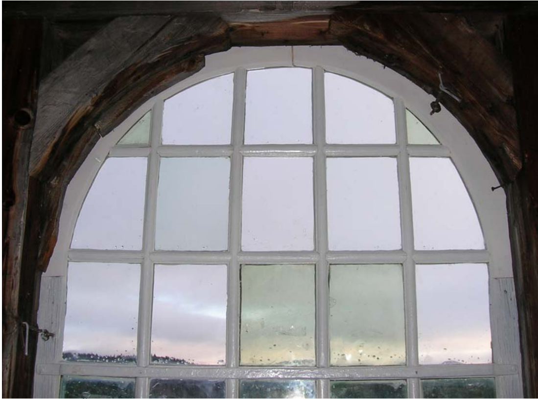
2007-12-04. Östra tornfönstret ommålat med utbytt överdel.
