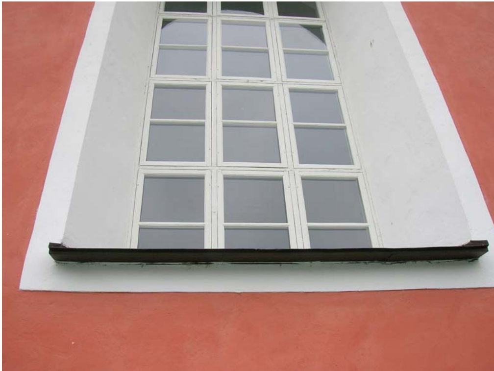
2006-07-03. Södra korfönstret inmonterat med färdigmålade skruvhuvuden.
