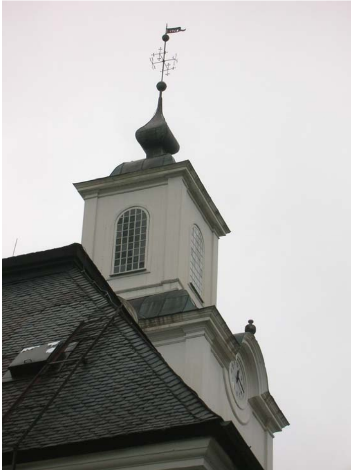
2006-10-02. Lanterninfönster mot öster före ommålning.
