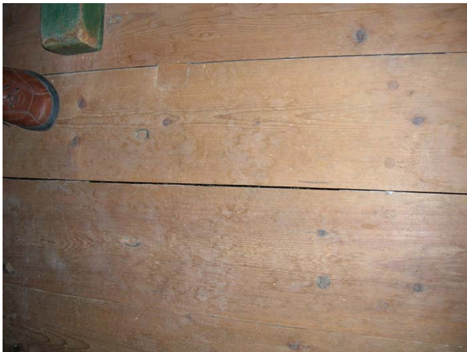
2007 06 23 före upptagning av golvet utmed östra väggen.
