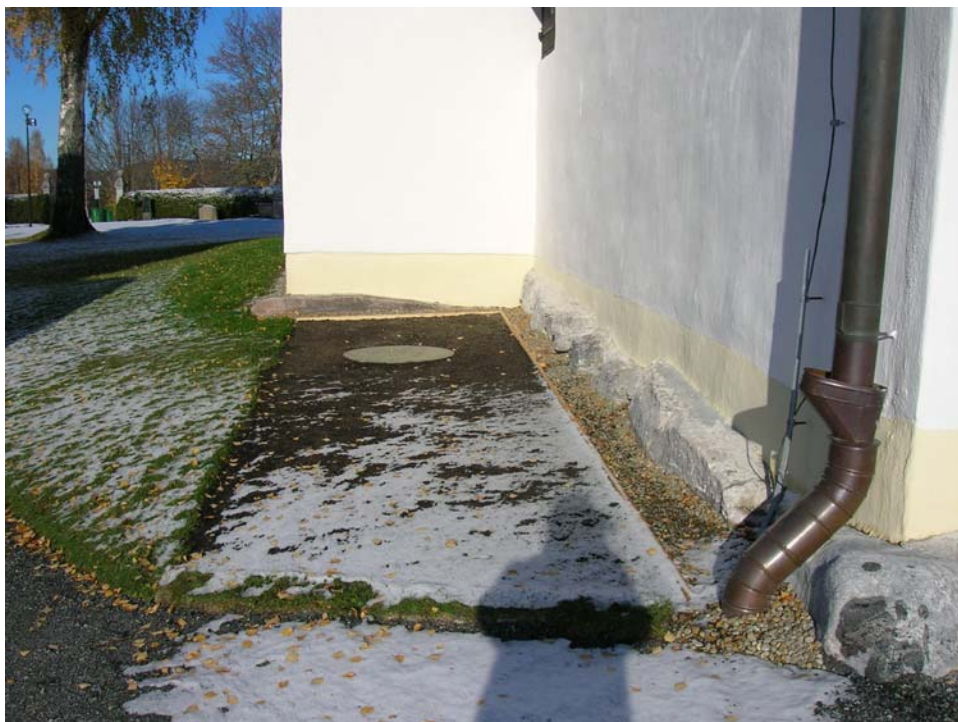
Efter isolering av grundmur mot väster. 2007-10-12.
