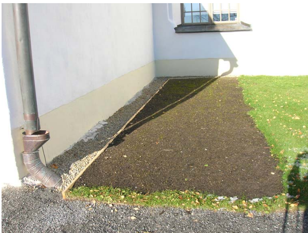
Efter isolering av grundmur mot öster. 2007-10-12.
