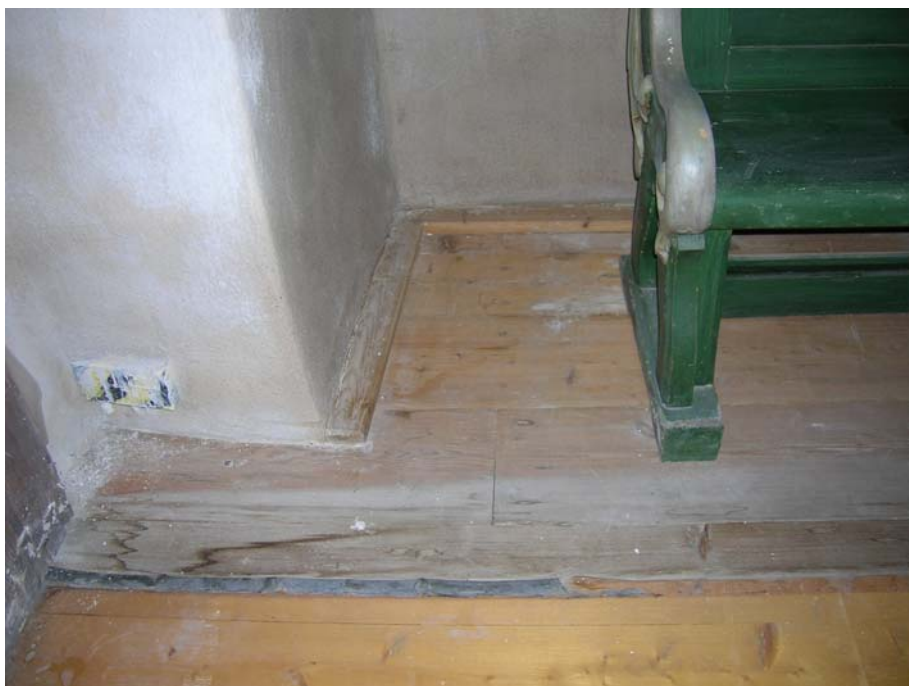
2007 06 23. Golv vid entrén till långhuset före demontering.
