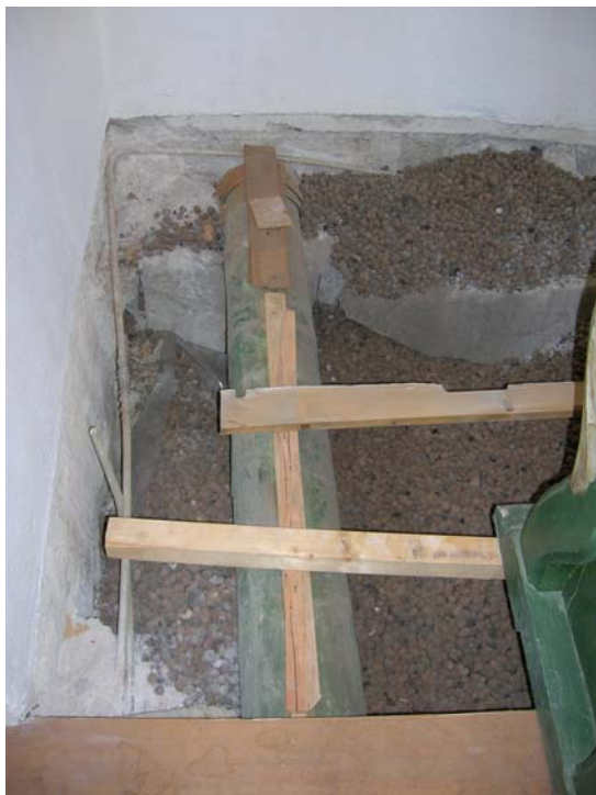
Isolering utmed vägg mot långhuset. 2007-09-11.
