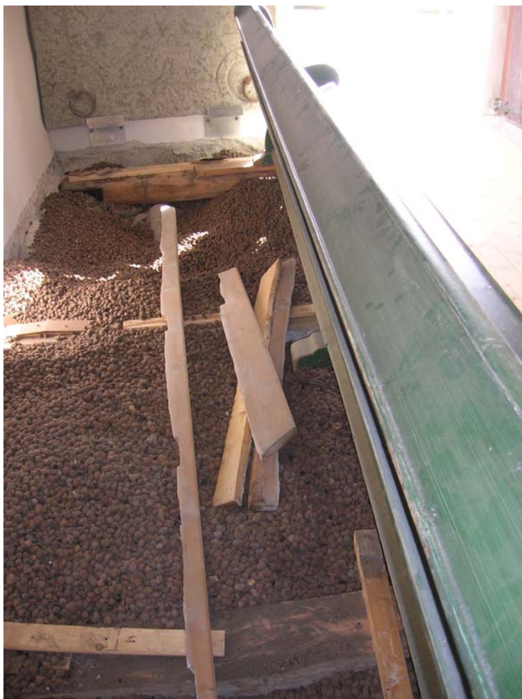
Befintlig isolering av leca utmed östra väggen. 2007-09-11.
