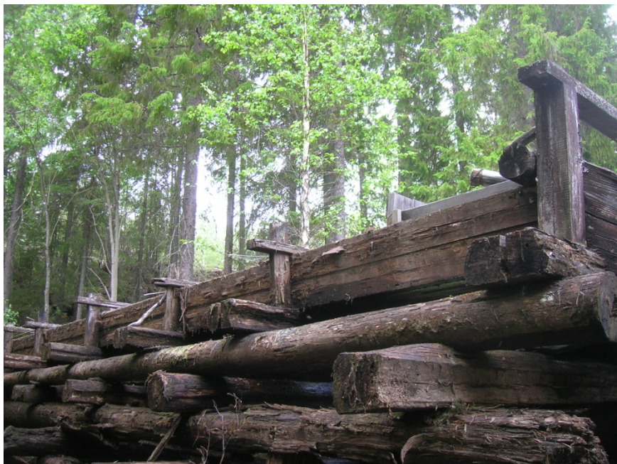
2011-06-14. Vattenrännans östra sida före rekonstruktion.
