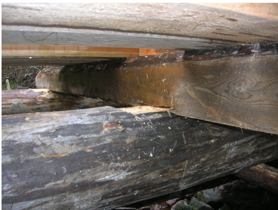
2011-10-12. Upplag av åsarna under rännan.
