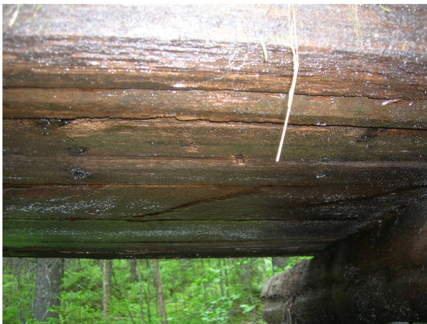
2011-06-14. Bräder på vattenrännans undersida.
