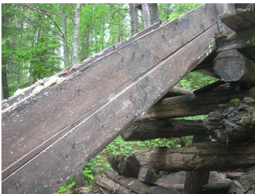
Vattenrännans västra sida före rekonstruktion. Änden av gammal telefonstolpe th.
