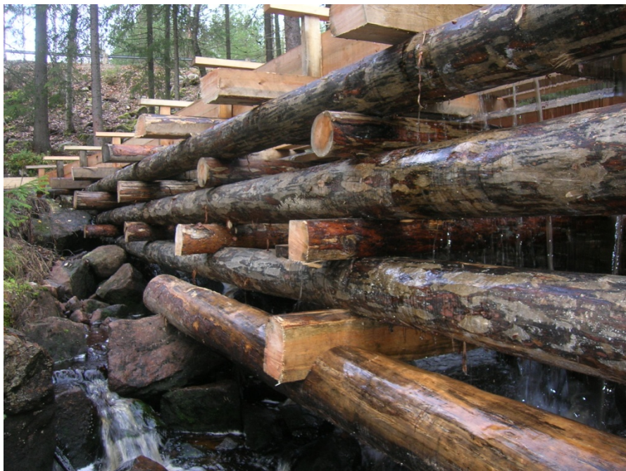
2011-10-12. Vattenrännans östra sida efter rekonstruktion.
