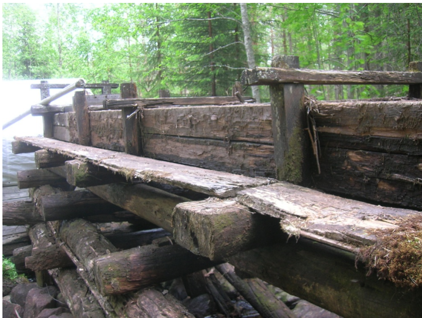
2011-06-14. Vattenrännans västra sida före rekonstruktion.
