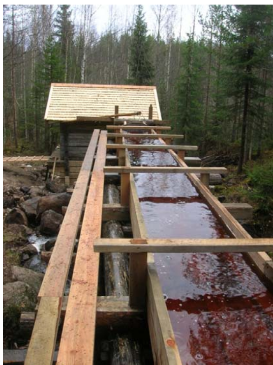
2011-10-12. Rekonstruktionen av vattenrännan.
