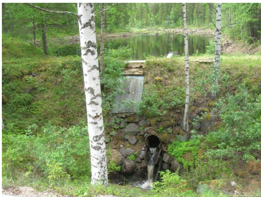
11 06 14. Dammens utlopp på ovansidan byvägen.
