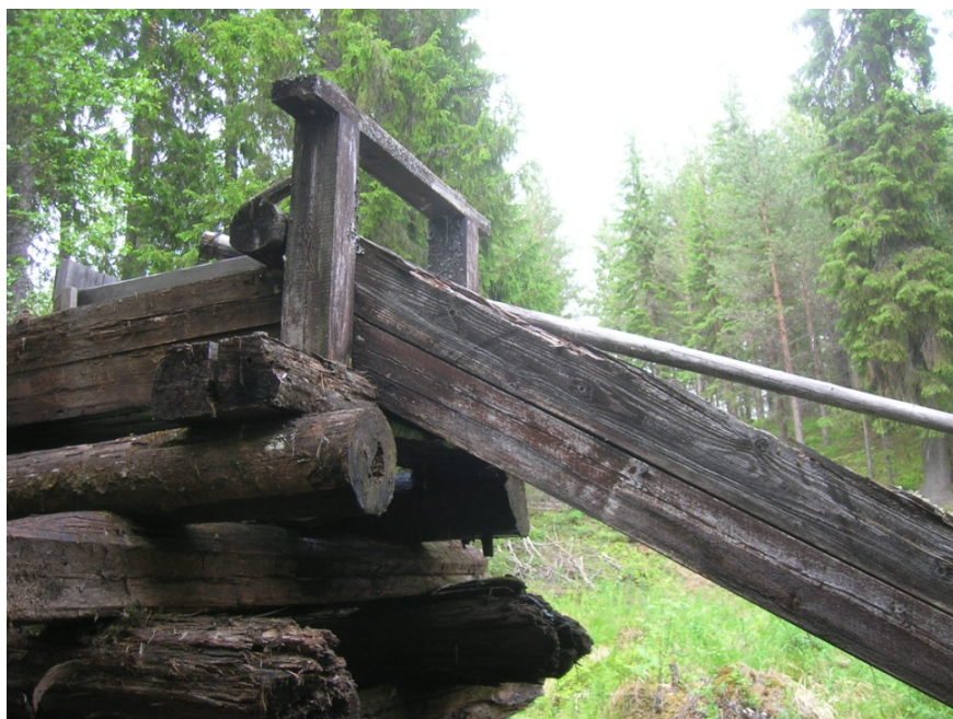
2011-06-14. Vattenrännans östra sida före rekonstruktion.
