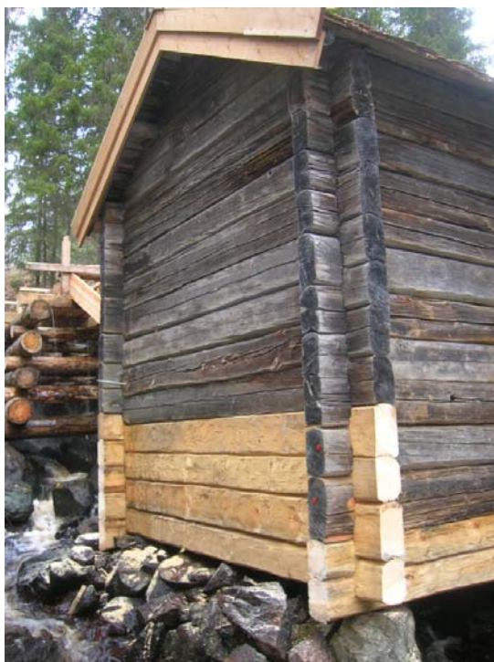
11 10 12. Östra väggen (kvarnhusets baksida).
