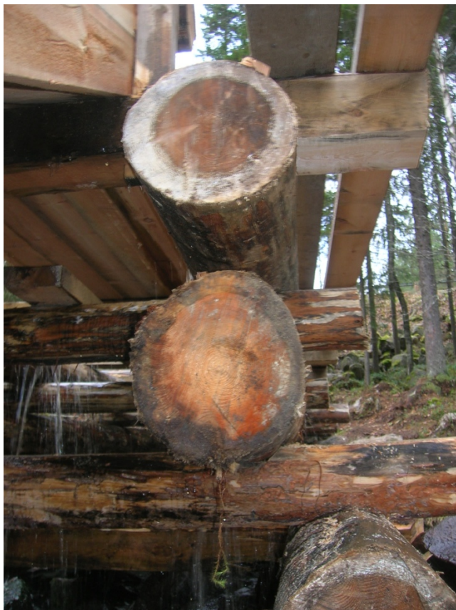
2011-10-12. Underbyggnadens kortsida mot kvarnen.
