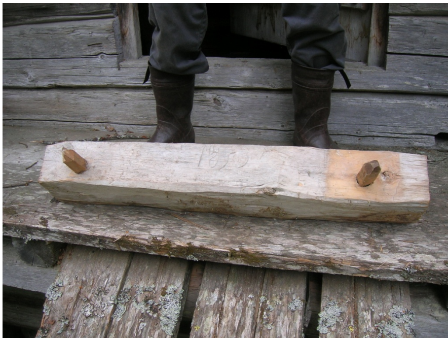
11 06 14. Stock med årtalet "1850" som har suttit under ingången på det tidigare kvarnhuset är den återstående resten av gamla kvarnhusets väggar.
