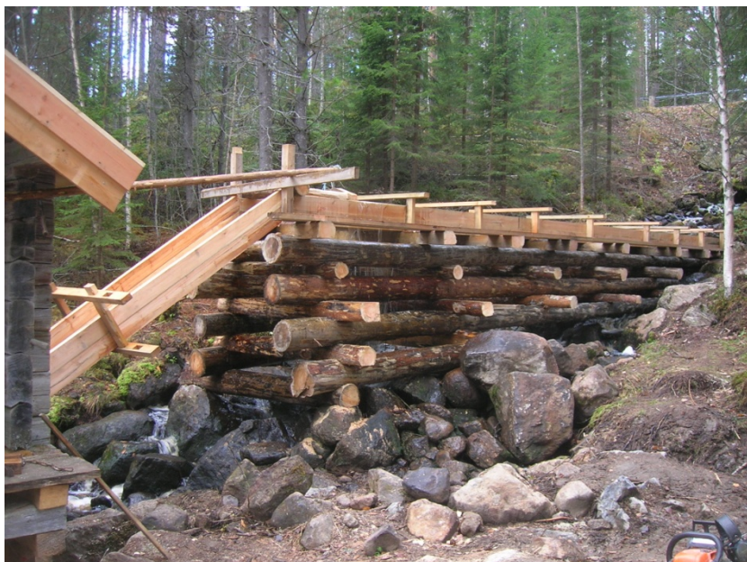
2011-10-12. Vattenrännans västra sida efter rekonstruktion.
