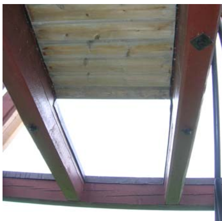
2006 10 02. Fotot visar glansvärde på tidigare plastfärgad yta i skyddat läge.
