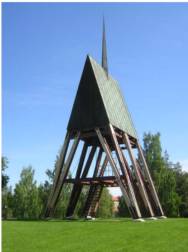
2006 07 01. Klockstapeln under utbyte av rötskadat virke.
