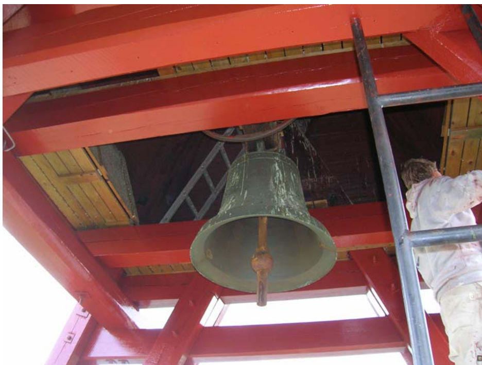
2007-07-02. Klockdäcket är ommålat med tre strykningar.
