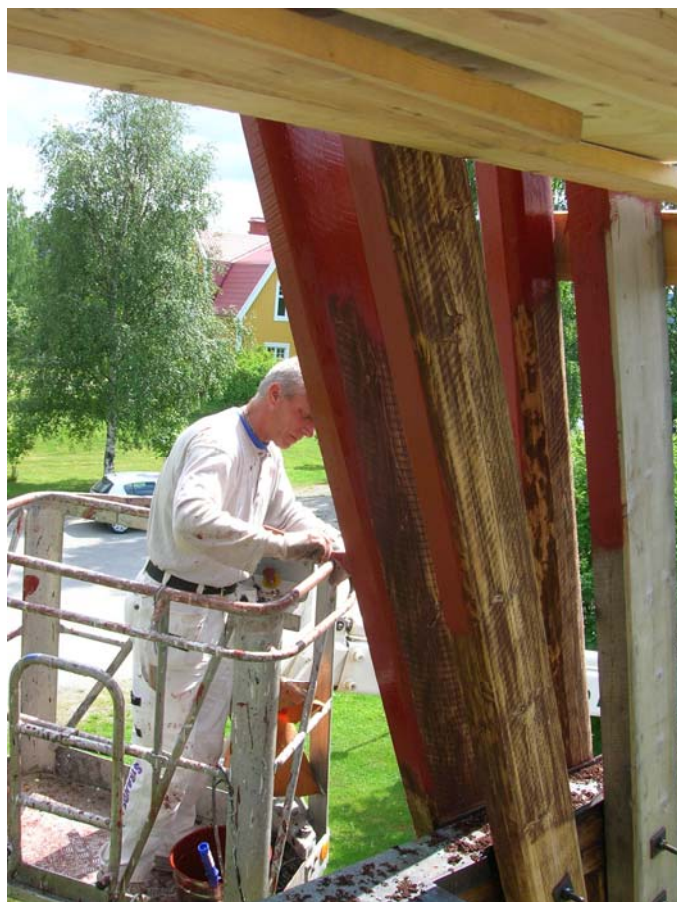
2007-07-02. Ommålning av klockstapelns östra fasad med linoljefärg.
