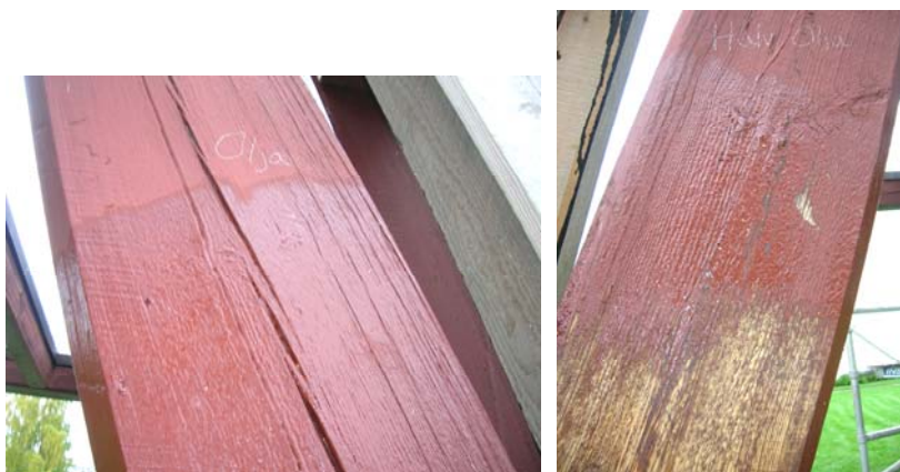
2006 10 02. Provytor för rengöring av plastfärg, till vänster med linolja till höger med halvolja före värmning / skrapning.
