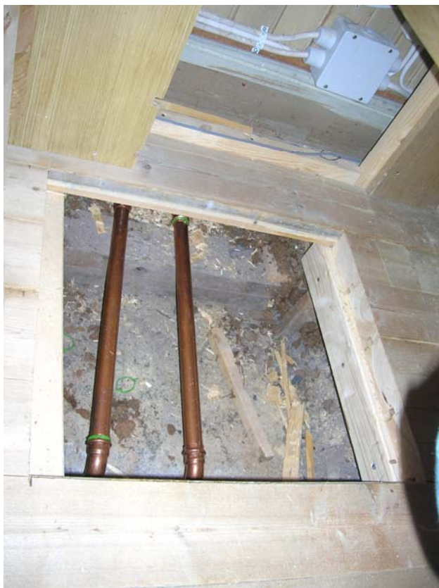
Ny inspektionsslucka i golvet, södra bänkkvarteret 2006 10 04.
