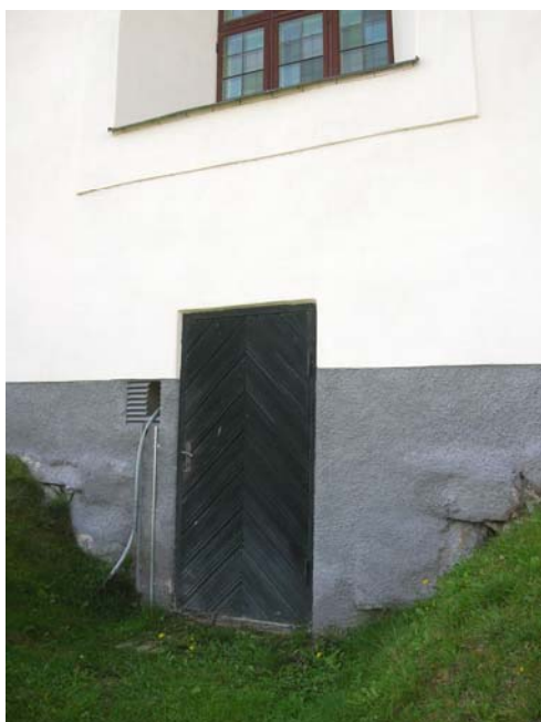
Pannrummet på norra sidan.
