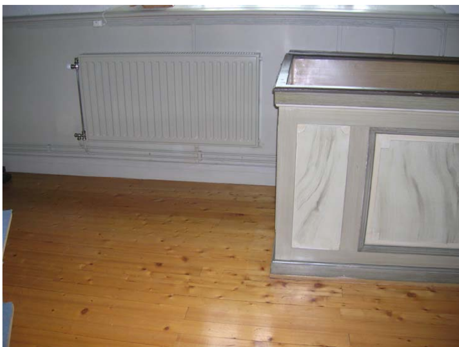
Norra korväggen efter byte till vattenburen radiator inmålad i väggens kulör.
