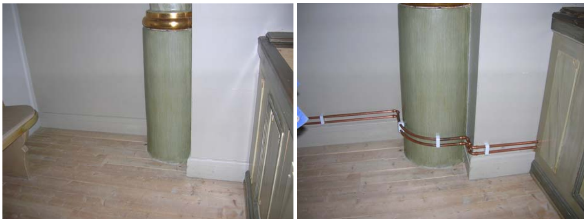
Läktarkolonn mellan bakersta bänkkvarteret på norra sidan före och efter installationerna (rören ännu ej målade). 2006 10 04. och 2006 10 30.
