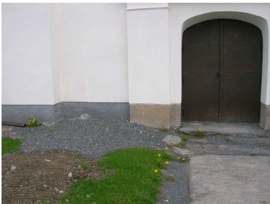
20070521. Södra porten och fasaden efter att markskiktet lagts tillbaka.
