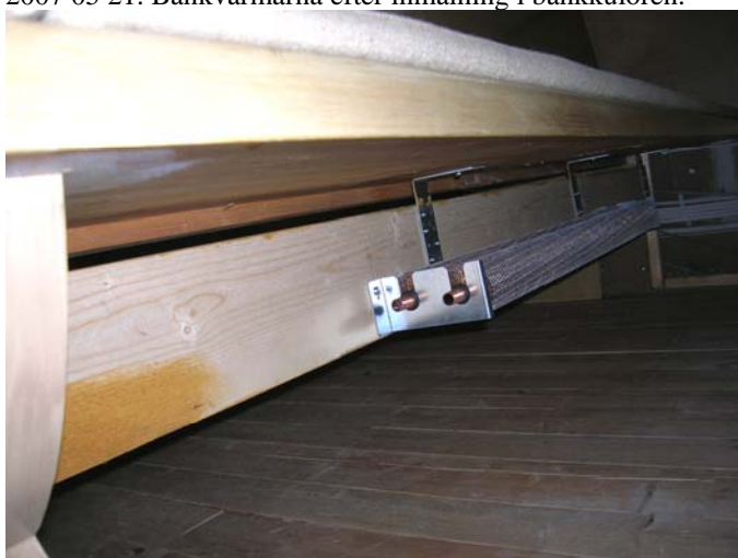
2006 10 04. De nya bänkvärmarnas fäste i bänkarnas undersidor.
