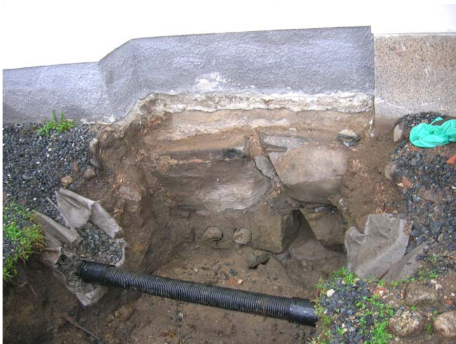
Håltagning i kyrkans södra grundmur väster om södra porten 2006 10 04.
