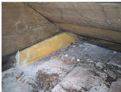
2004 10 19. I nordvästra hörnet byttes en liten del av hanspetsen. Fotot till vänster (ovan) visar före utbyte av virke med rötskadat trä nederst. Fotot till höger efter iskarvning av friskt trä.
