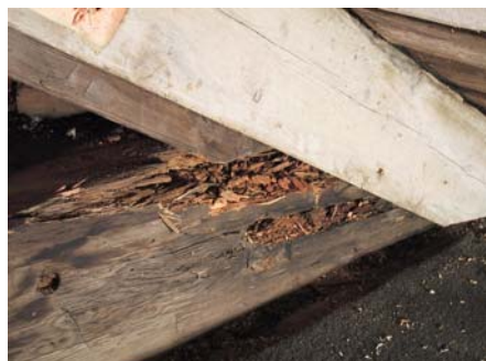
Rötskadad hanspets före reparation.
