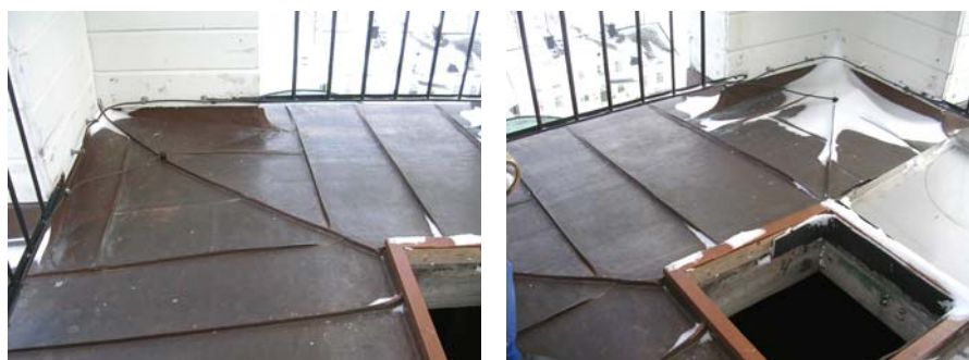
SV hörnet. Lanterninens mellantak, efter byte till kopparplåt. NV hörnet.
