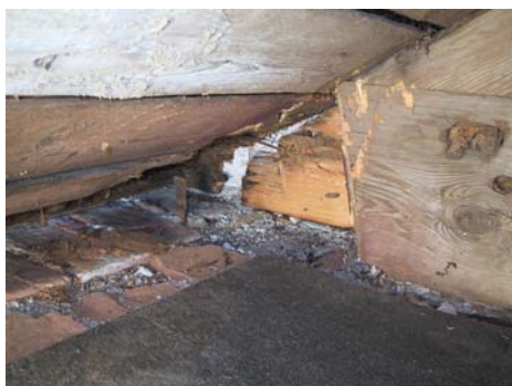
2004 10 19. I sydvästra hörnet (vänster sida klockan) byttes cirka 1,5 meter rote och cirka 3 decimeter av hanspetsen på den liggande bjälken. Rötskadad del är borttagen. Frisk virkesdel (kil) iskarvades efter fotograferingen.
