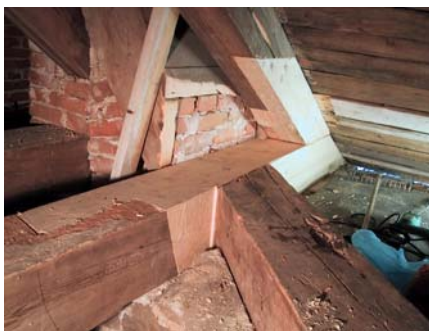
2004 01 07. Rötskadat virke i hanbjälke och sträva iblandas. Sydöstra hörnet.
