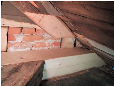
2004 01 07. Rötskadat virke i hanbjälke och sträva iblandas. Sydöstra hörnet.
