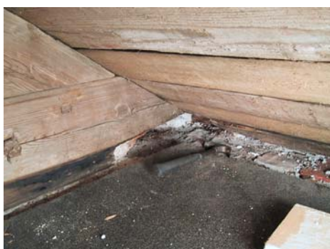
2004 10 19. I nordvästra hörnet byttes en liten del av hanspetsen. Fotot till vänster (ovan) visar före utbyte av virke med rötskadat trä nederst. Fotot till höger efter iskarvning av friskt trä.
