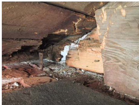
2004 10 19. I sydvästra hörnet (vänster sida klockan) byttes cirka 1,5 meter rote och cirka 3 decimeter av hanspetsen på den liggande bjälken. Rötskadad del är borttagen. Frisk virkesdel (kil) iskarvades efter fotograferingen.
