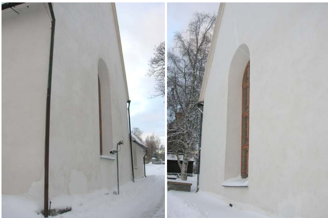
Underhållsarbeten utanför entreprenaden: Spricklagningar gjorda på V gavelfasad resp. Ö fasaden t h.
