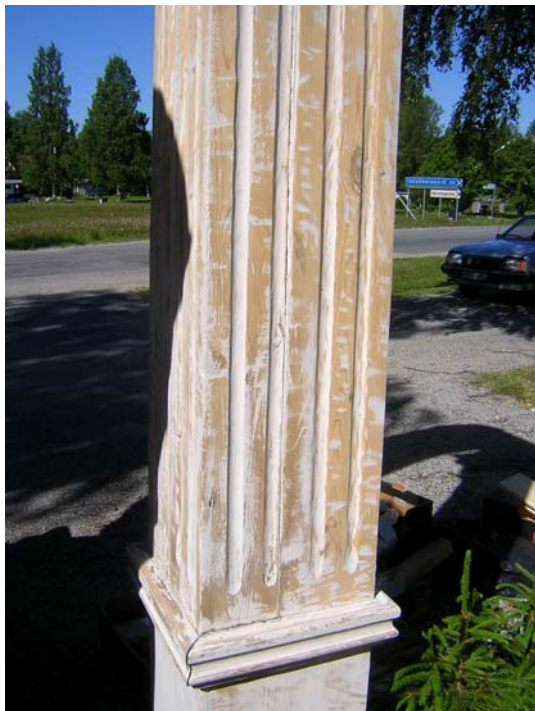
Norra kolonnen i centrala bågen rengjord för ommålning.
