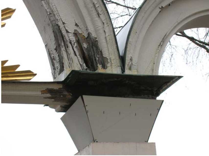
Norra bågarna före reparation 2005 05 03. Foto mot väster (atrapp för kapitäl under rekonstruktion).
