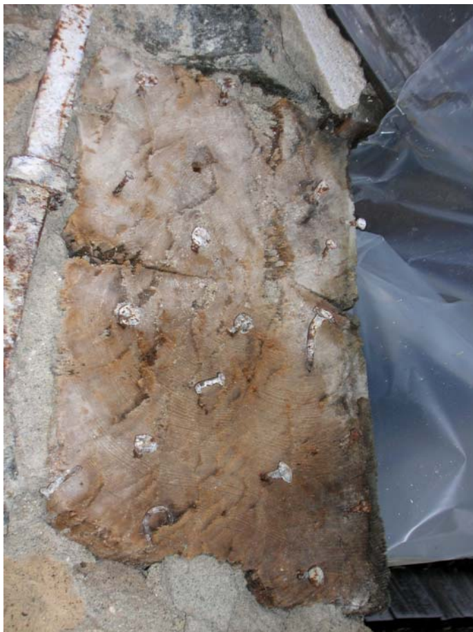
Änden på tätvuxen bjälke längs norra takfoten i NO hörnet av långhuset.
