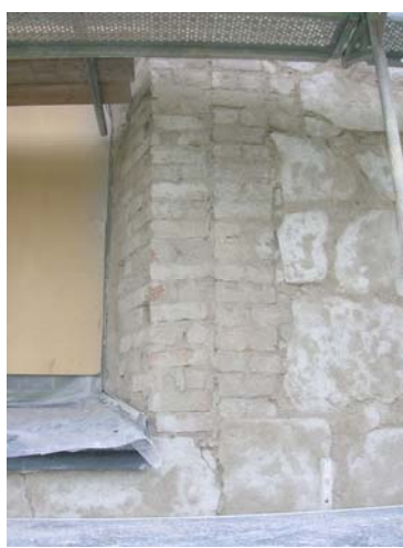
20070521. Grundad fasadyta som stått 4 dagar kring fönster, på östra fasaden.
