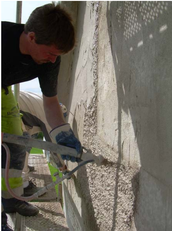
20070531. Ytputsen sprutas på och jämnas efter med rivbräda.
