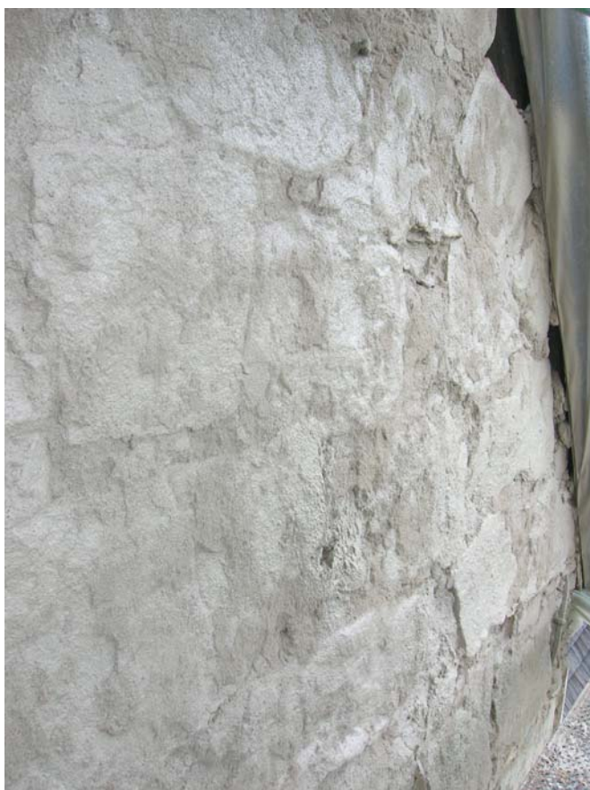
20070515. Grundad fasadyta intill norra takfallet.
