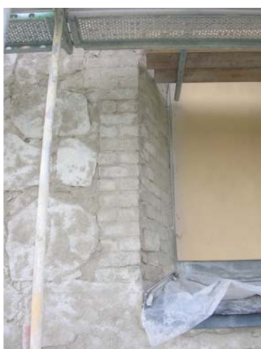
20070521. Grundad fasadyta som stått 4 dagar kring fönster, på östra fasaden.
