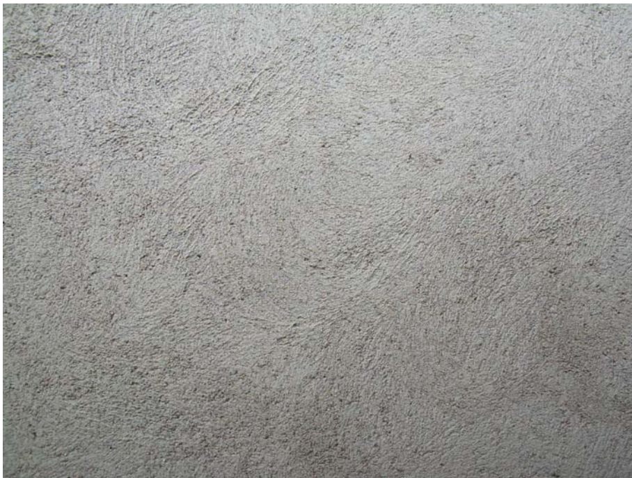
20070531. Färdig ytputsad yta under gavelröstet.
