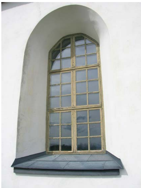
2007-05-21. Fönster S fasaden före ommålning.
