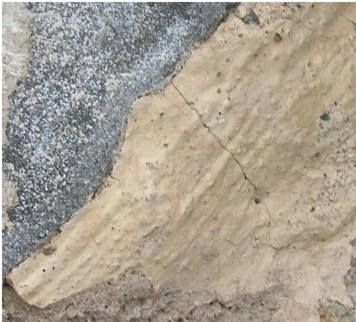
Äldre putsrest med kalkfärg och märken efter murarkvast i NO hörnet.
