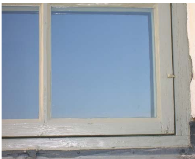
2007-07-03. Fönster S fasaden efter ommålning.
