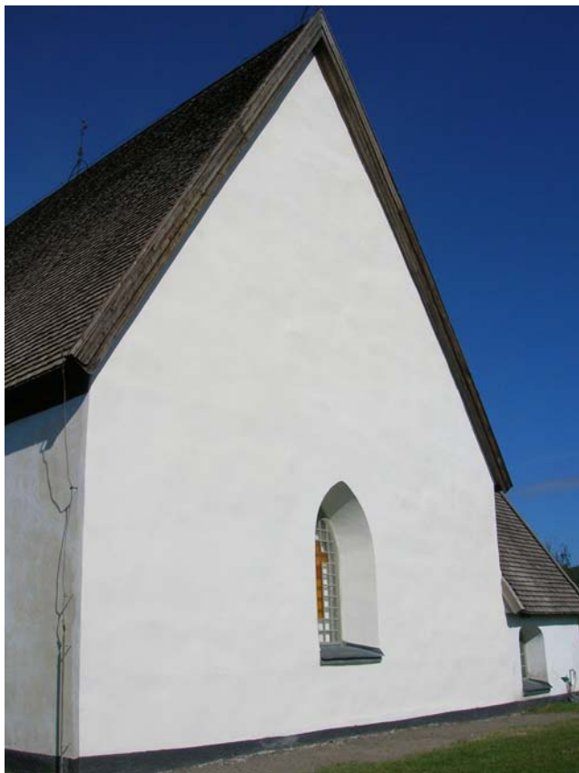
2007 07 03. Östra gavelfasaden några dagar efter avfärgning.
