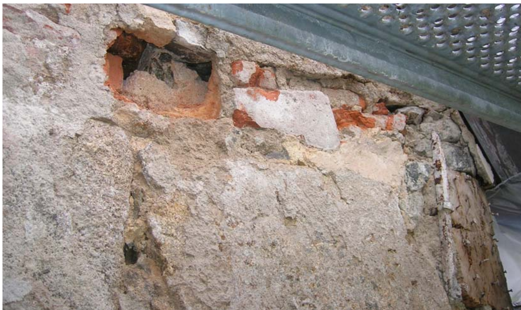
20070515. Rengjort murverk före grundning. Skador i murverket sätts igen med tegel.
