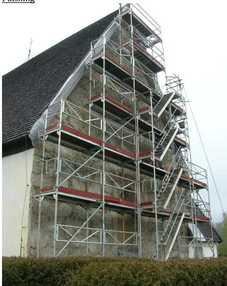
20070515. Rengjord fasad, grundning med spruta påbörjas.
