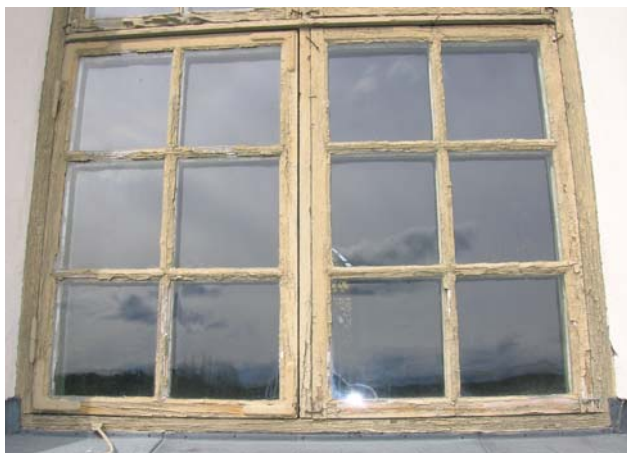
2007-05-21. Fönster S fasaden före ommålning.
