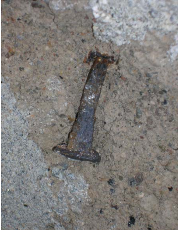
Ett flertal handsmidd spik troligen som som fäste för bruket.
