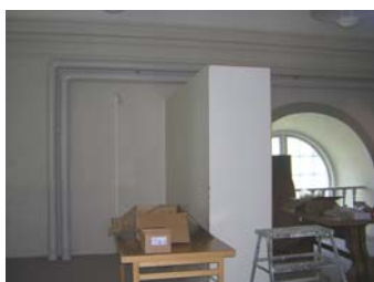
Läktarens södra vägg.
