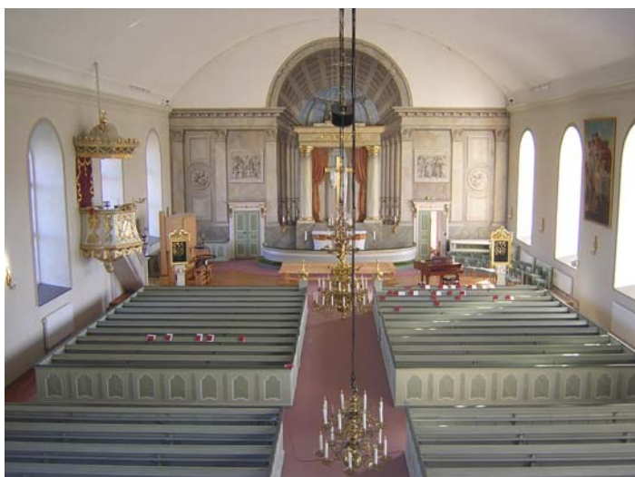
Kyrkorummet efter installationer och radiatorer efter väggarna. Rören in till sakristian bakom koret är ej synliga i långhuset.
