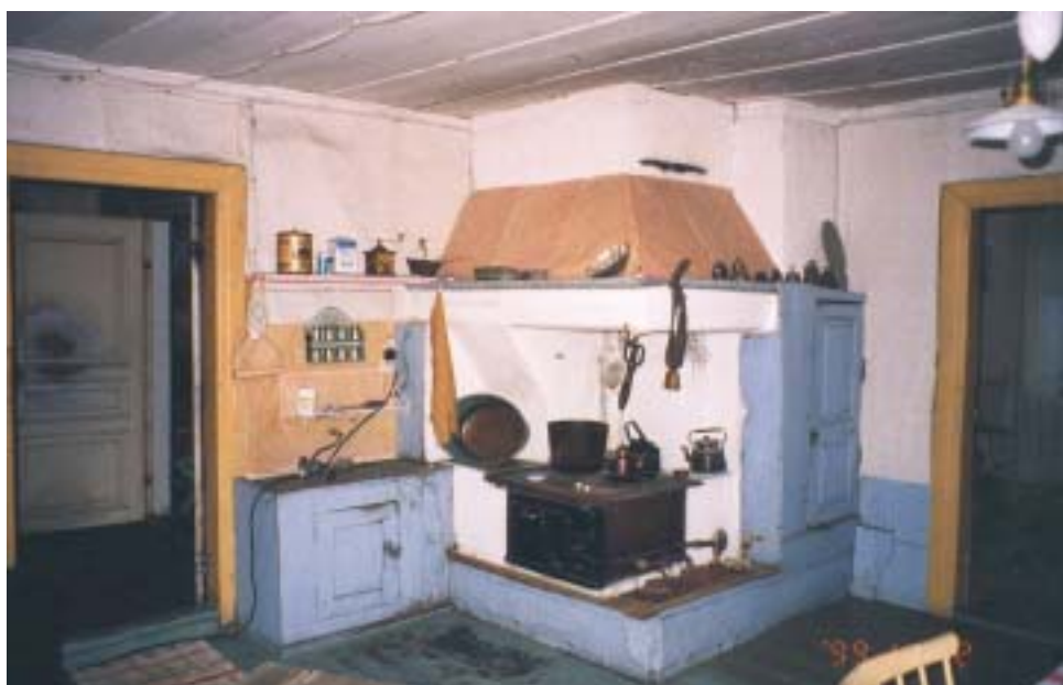
Köket i Kungsgården 19:2 före åtgärder
