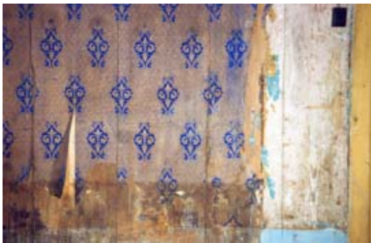
Äldsta pappspämnda tapetlagret på ...
