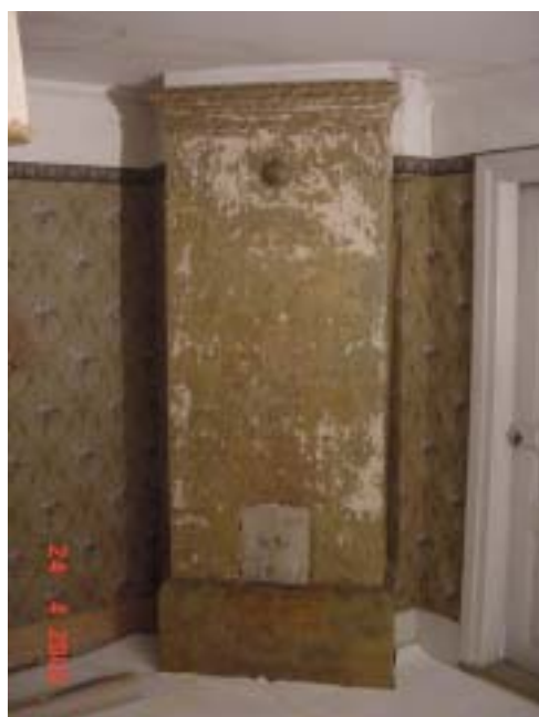
Rörspis i salen före åtgärder
