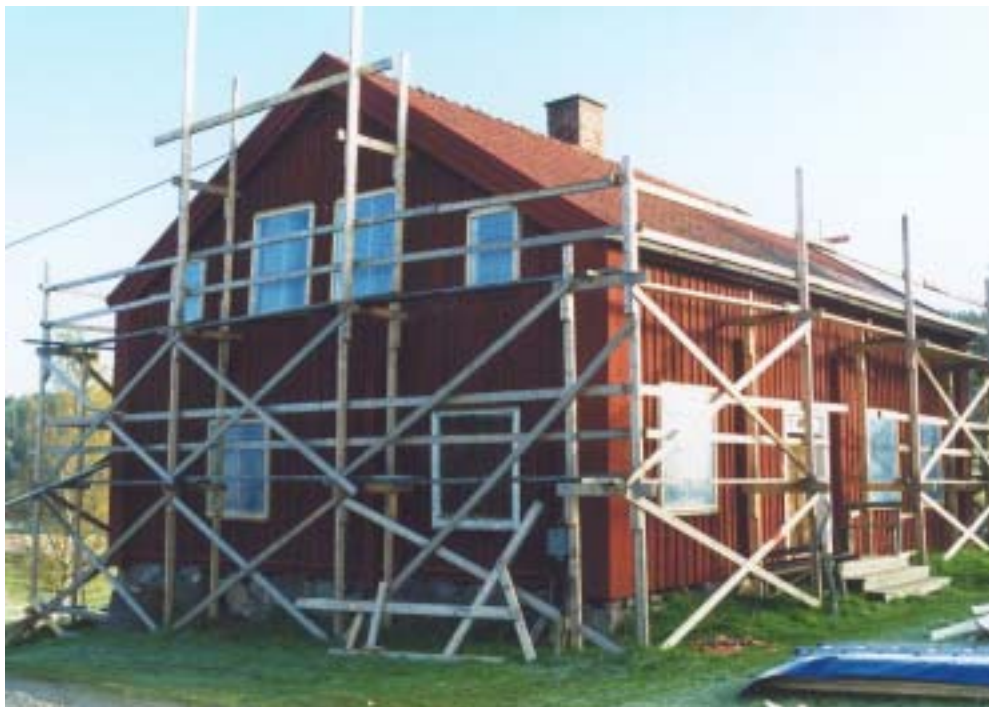
Kungsgården 19:2 efter restaurering
