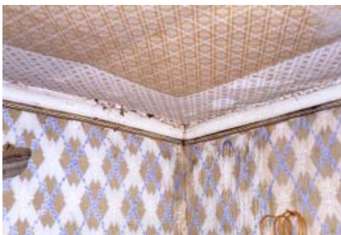
Salens tapetserade väggar och tak före åtgärd
