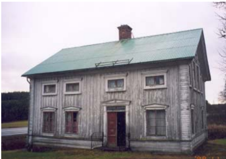
Skoved 3:2 före restaurering
