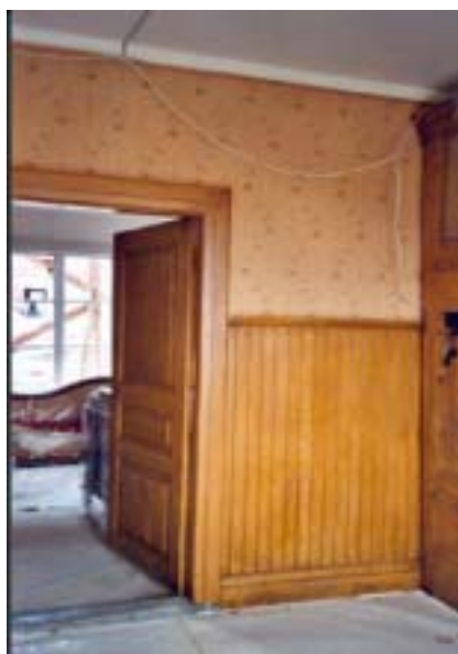
Köker efter åtgärder
