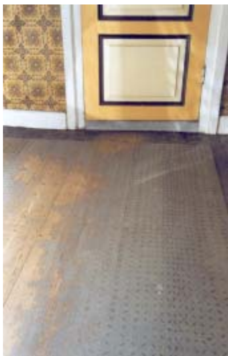
Golv i hall på övervåning före.....
