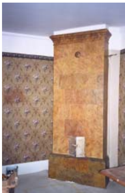
Rörspisen efter åtgärder
