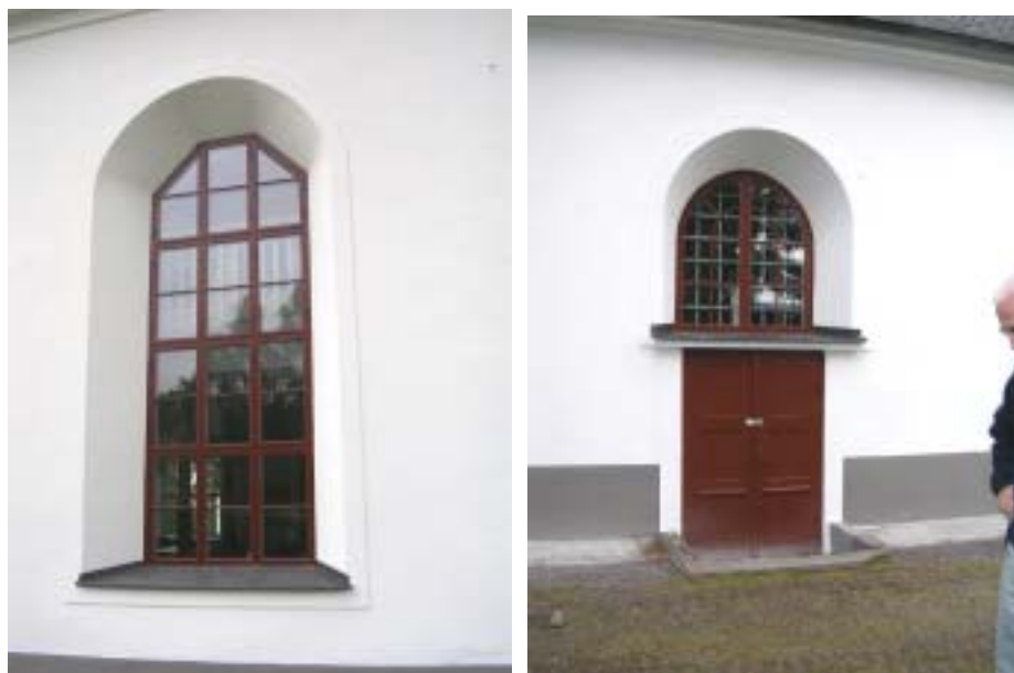
Fönster norra fasaden och sakristiedörren efter ommålning.
