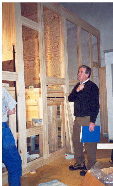
Orgelns norra sidostycke under uppbyggnaden (t v).
