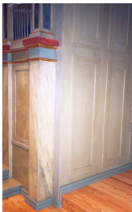
Sockelns anslutning mot det nya golvet (dubbel list) och fogarna före justeringar (t v). T h: Orgelns NO hörn efter ombyggnaden och ny golvbeläggning av skiktlimmat lärkträ.
