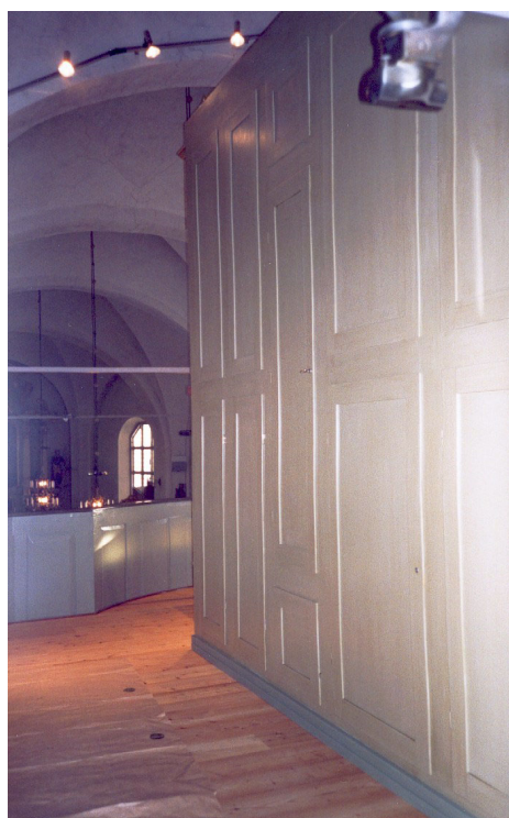
Orgelns norra nybyggda sidostycke färdigmålad (t v). T h: Breddningen av läktarorgelns södra sida, framsidan är ursprunglig ej åtgärdad orgelfasad samt nya spelbordet och bänken.
