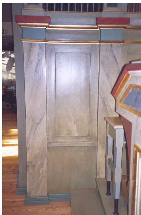
Orgelns norra nybyggda sidostycke färdigmålad (t v). T h: Breddningen av läktarorgelns södra sida, framsidan är ursprunglig ej åtgärdad orgelfasad samt nya spelbordet och bänken.
