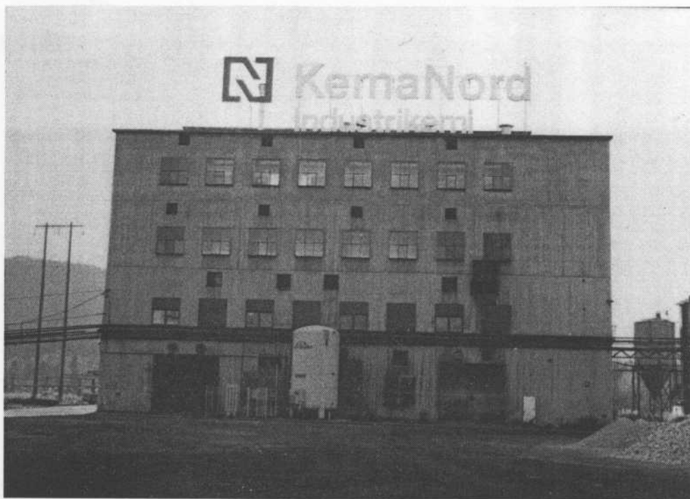
Keramfabriken vid Ljungaverksindustrin. Byggnad nr 362.
