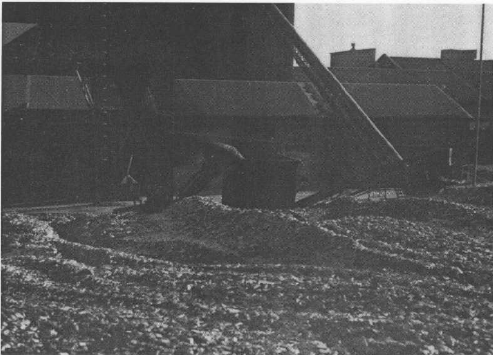
Råvaruupplag av flis. Här syns transportören som leder till flissilon.
