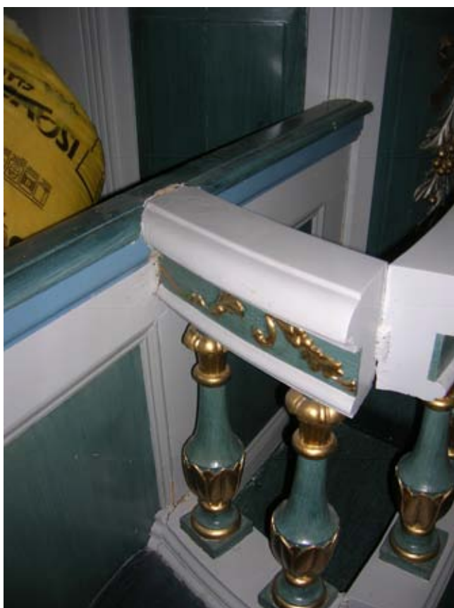
2010-06-07. Återmonterad altarring på norra sidan före bättringsmålning.
