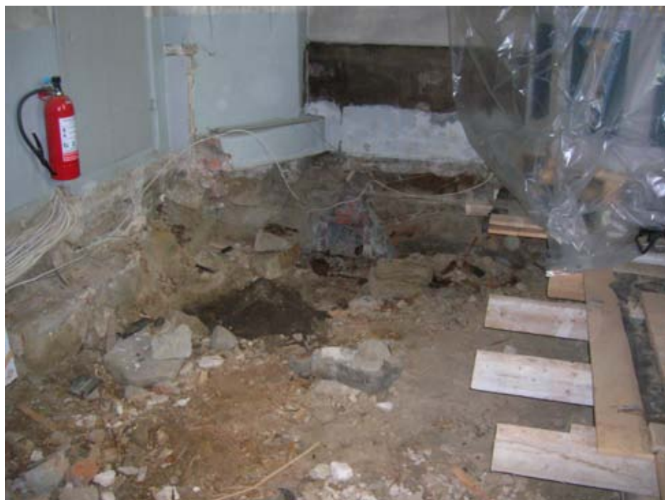
2010-04-27. Kyrkvärdsbänken på norra sidan altaret borttagen inför sanering. Sakristians dörr tv.
