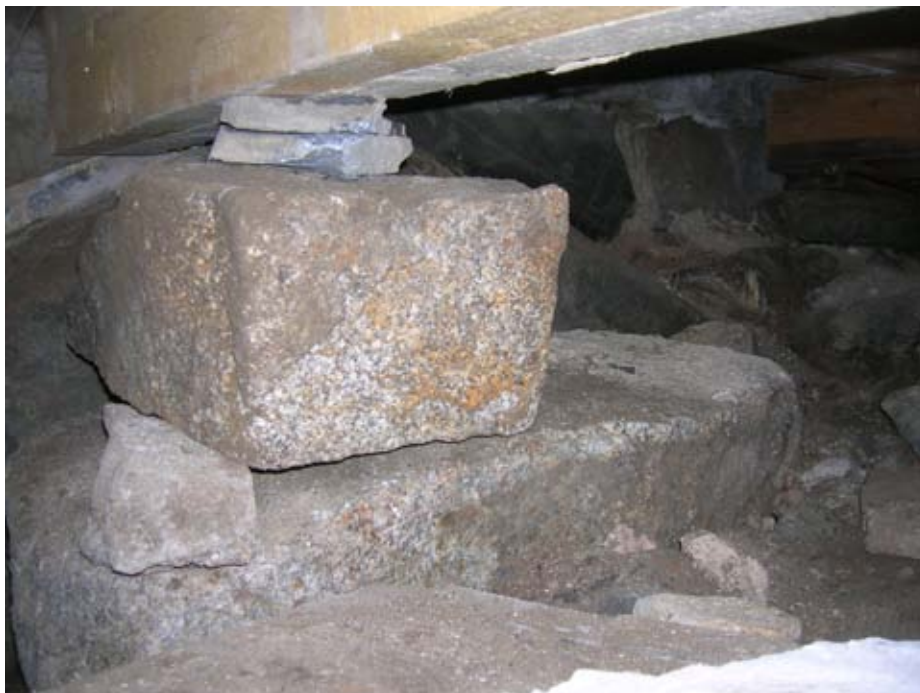
2010-05-18. 2:a bärlinan från norra väggen ersatt med likvärdig, borttaget svampskadat material och tillbakalagda grundstenar.
