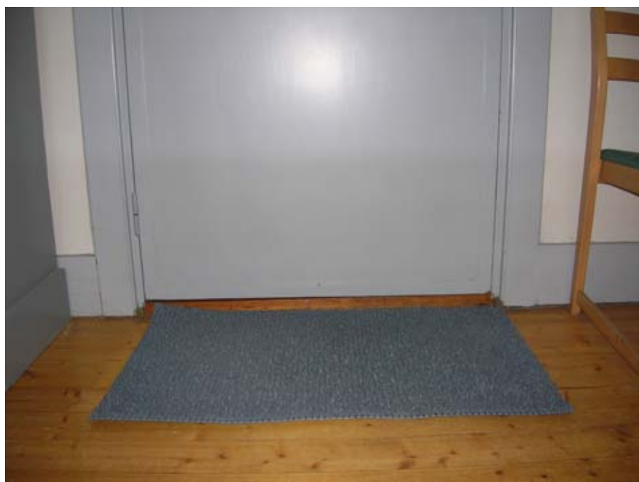
2010 04 06. Detalj, socklar och dörrfoder, sakristians dörr mot väster.
