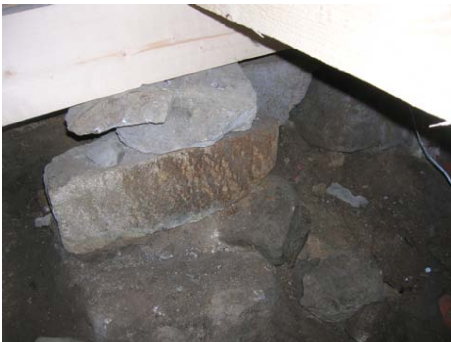
2010-05-18. Tillbakalagda grundstenar i kyrkans NO hörn efter sanering och ersatt bärlina och golvås närmast sakristian (under dörr till sakristian).
