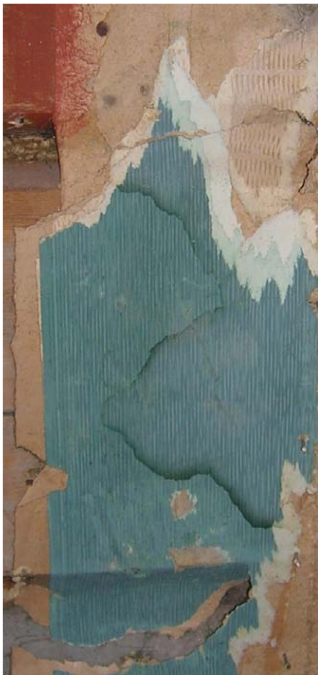
2010-06-07. Rester av grön, därunder beige tapet på spännpapp, södra väggen vid dörröppningen.
