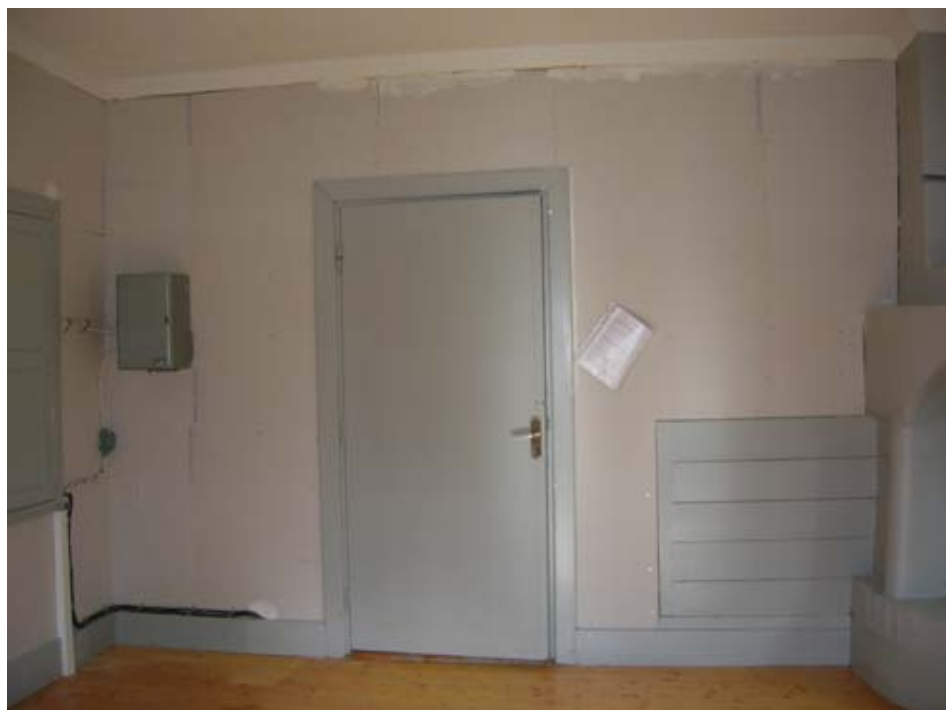
2010-06-30. Gipsbeklädd vägg mot väster före målning, återmonterade dörrfoder och taklister. Taket är ej helt plant.
