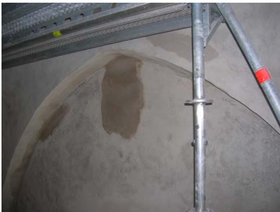
2010 09 20. Färdiga putslagningar ovanför söderfönster på läktaren.
