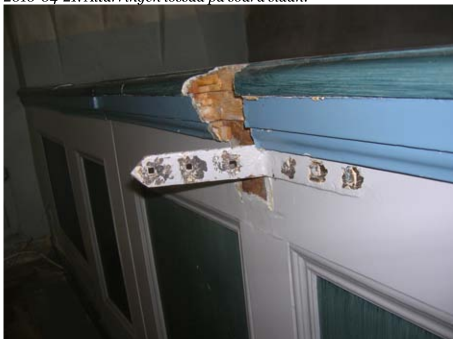
2010-04-21. Handsmitt vinkeljärn för altarring på norra sidan.
