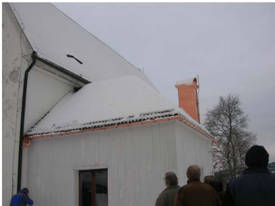
2010-11-18. Hängrännor med gavelbeslag på sakristian, ny skorstensbeklädnad med snöskydd.
