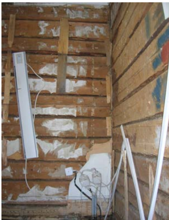
2010-06-07. Hörnet på östra väggen, kvarbliven regel och färg. Spikrad efter tidigare spännpapp.
