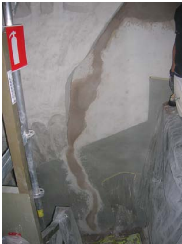
2010 09 20. Slutförd spricklagning vid läktartrappan.
