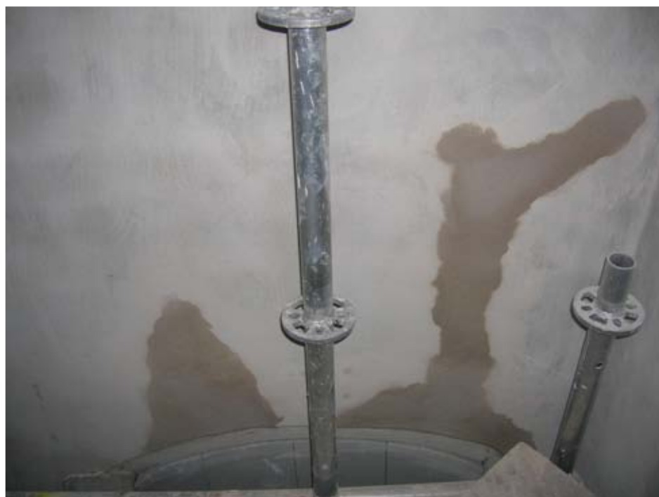
2010 09 16. Putslagningar ovanför dörren till sakristian.
