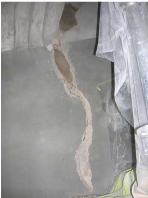
2010 09 16. Pågående spricklagning vid läktartrappan.
