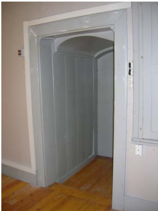
2010-06-30. Gipsvägg mot söder före målning, återmonterade snickerier.
