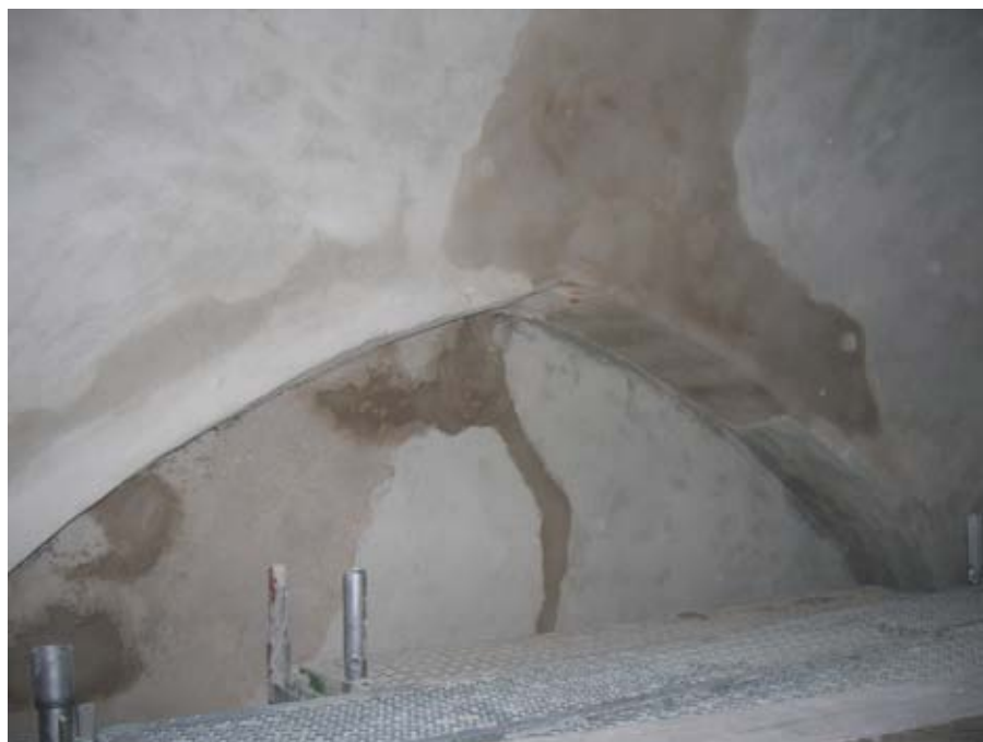
2010 09 16. Putslagningar ovanför valvbåge, norra läktarväggen.
