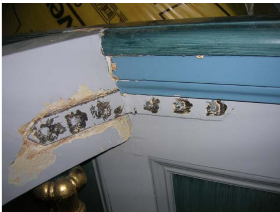
2010-06-07. Insidan av återmonterad altarring på norra sidan före bättringar.
