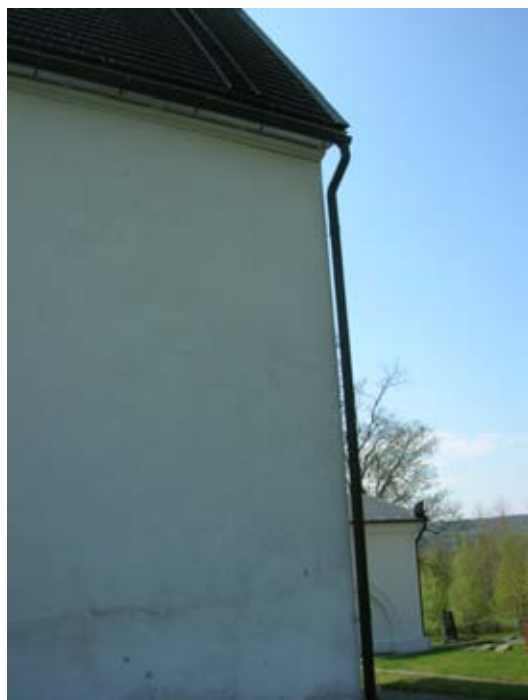
2010-05-18. Kyrkan har sedan tidigare stuprör av koppar av sentida tillverkning. Kyrkans NV hörn.
