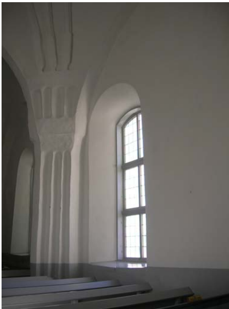
2010 11 04. Södra väggen efter ommålning.
