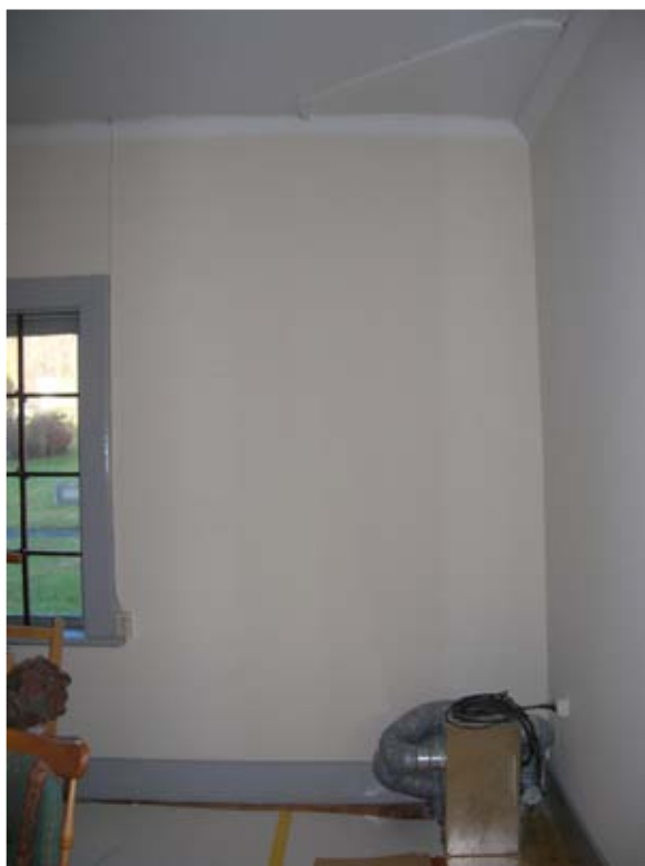
2010 11 04. Sakristians östra vägg efter målningsarbeten.
