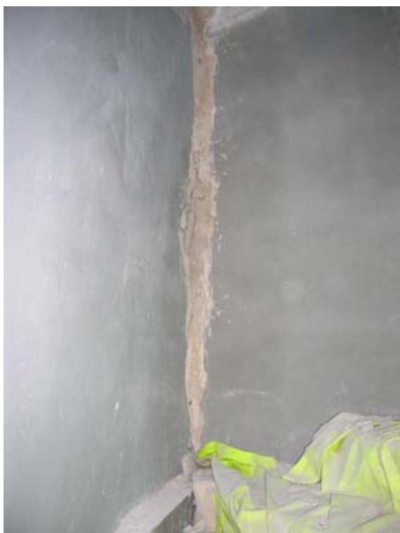
2010 09 16. Pågående spricklagning i hörnet vid läktartrappan.
