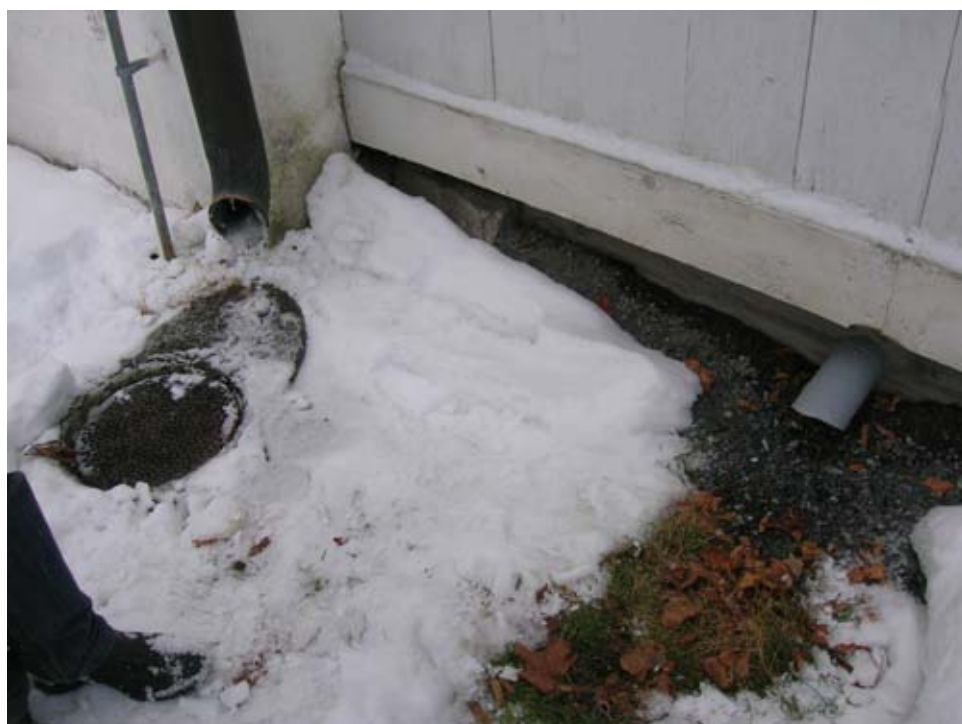
2010-11-18. Befintlig brunn och stuprör vid kyrkans östra grund. Värmeslinga Är nedlagd. Genom det grå röret kommer varmluft från avfuktningsskåpet.
