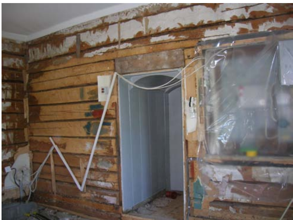
2010-06-07. Sakristians södra vägg efter borttagen svampinfekterad träfiber.
