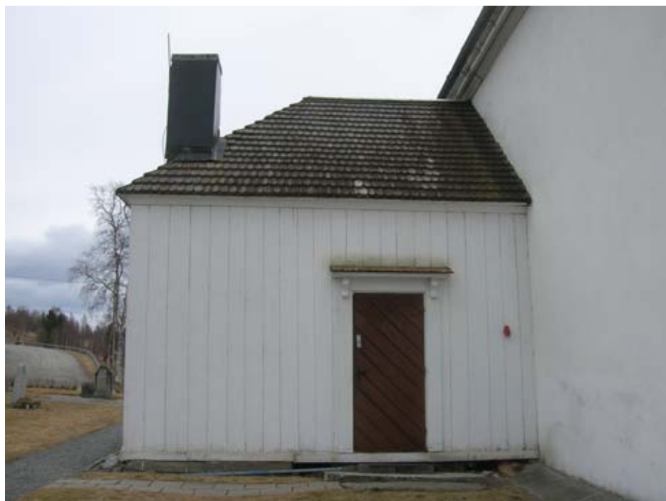
2010-04-27. Sakristians västra fasad före åtgärder.
