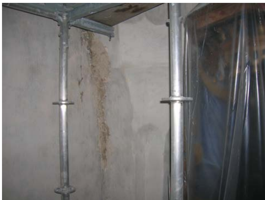
2010 09 16. Pågående spricklagningar vid pilaster väster om predikstolen.
