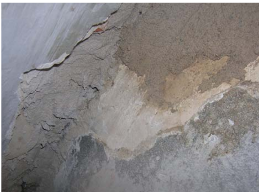
2010 09 16. Detalj, gammal kalkavfärgad puts under den sentida putsen. Valvbåge ovanför söderfönster längst i väster.
