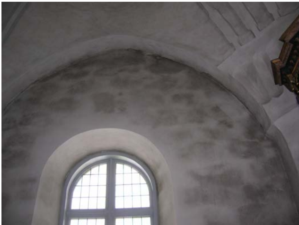
2010-04-06. Norra långhusväggen väster om predikstol.
