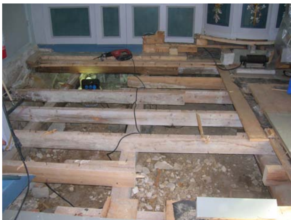
2010-04-21. Bärlinor och golvåsar under korgolvet närmast norra muren mot sakristian. Före sanering.
