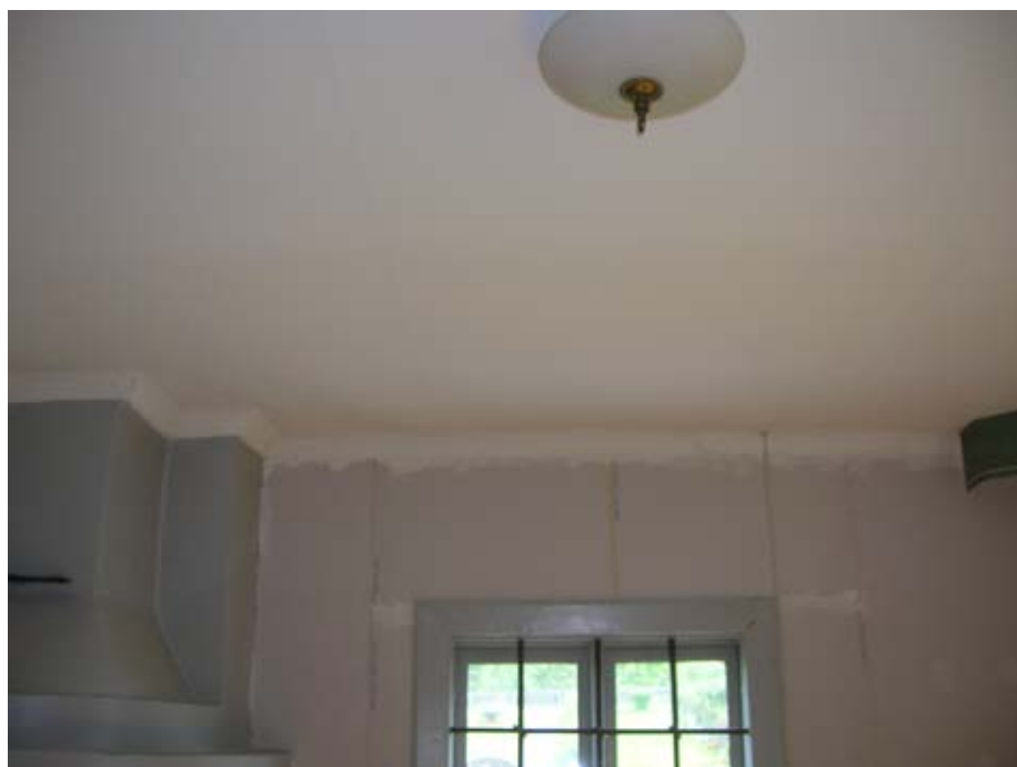
2010-06-30. Gipsvägg mot norr före målning, återmonterade fönsterfoder och taklister.
