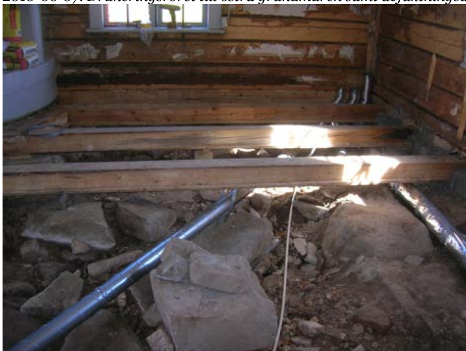
2010-06-07. Grunden mot norra väggen. NO hörnet där avfuktningssaggregat placeras i ett skåp.
