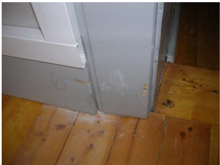
2010-06-30. Återmonterad golvsöcket och dörrfoder i sakristian mot passage till koret (före ommålning).
