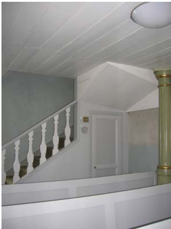
2010 04 06. Förråd under läktartrappan där ett avfuktningssaggregat installeras.
