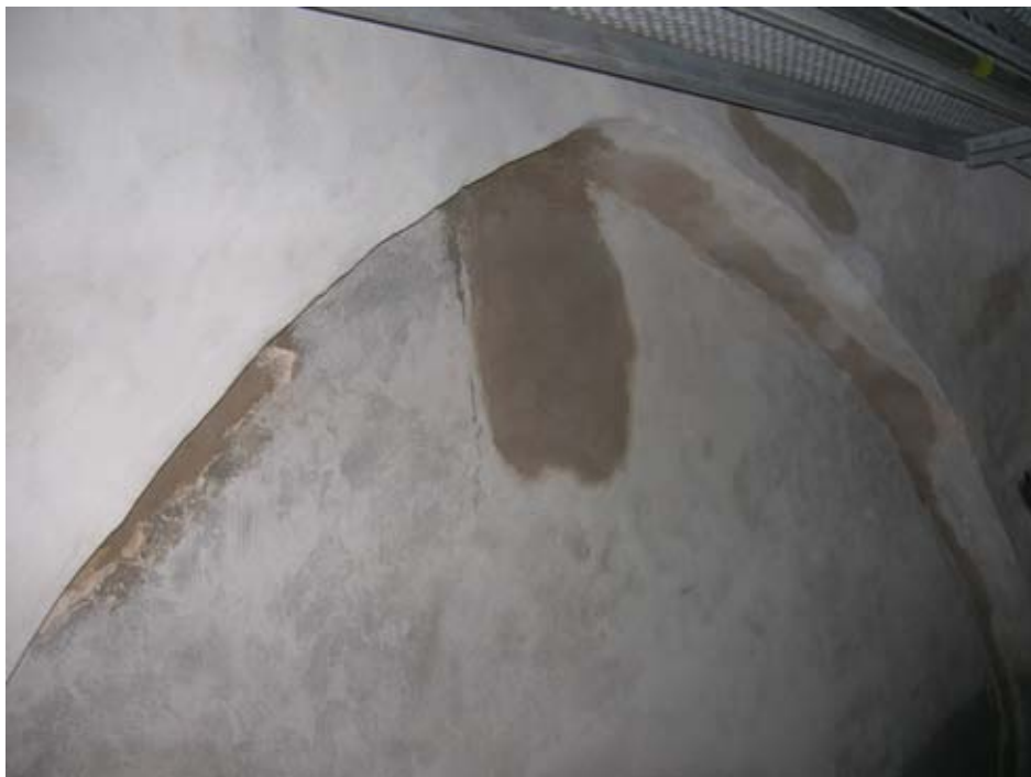
2010 09 16. Pågående putslagningar ovanför söderfönster på läktaren.
