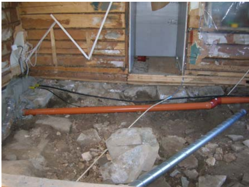
2010-06-07. Dräneringsrör från sakristians västra till östra grundmur.
