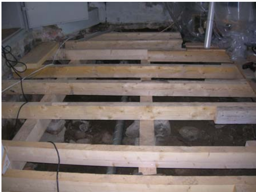
2010-05-18. Nya bärlinor och golvåsar, korets norra del. Efter sanering.
