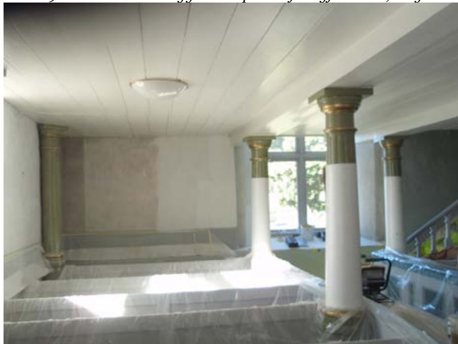
2010 09 20. Renborstad väggyta tv, uppstrykningsprover bredvid.
