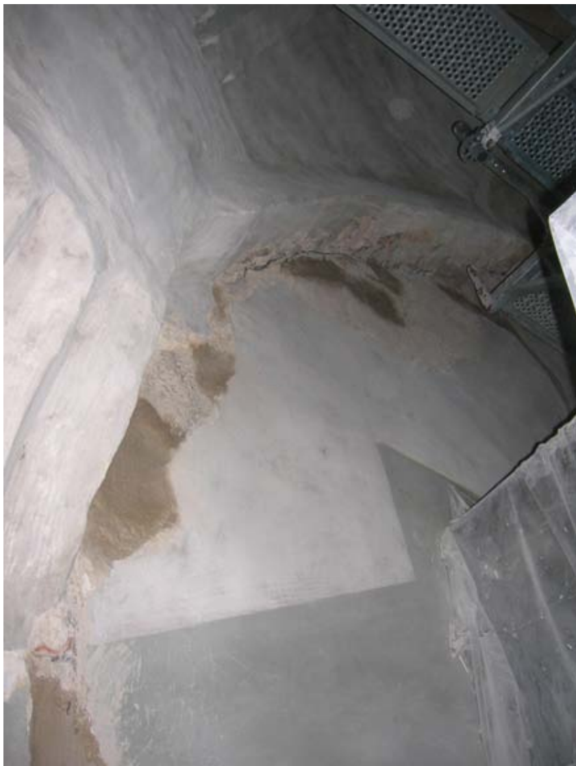
2010 09 16. Pågående spricklagning vid läktartrappan.
