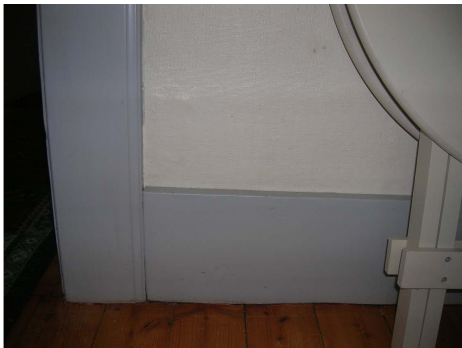
2010 04 06. Detalj, socklar och dörrfoder, sakristians passage mot kyrkorummet.
