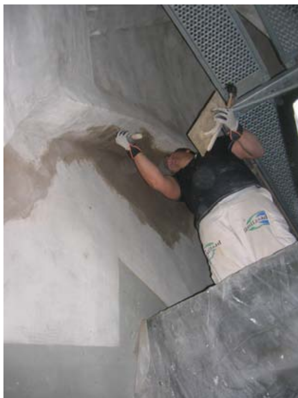
2010 09 20. Lagningens ytputs görs färdig i valvbåge, norra läktarväggen. Lagningen ovanför har börjat vitna.
