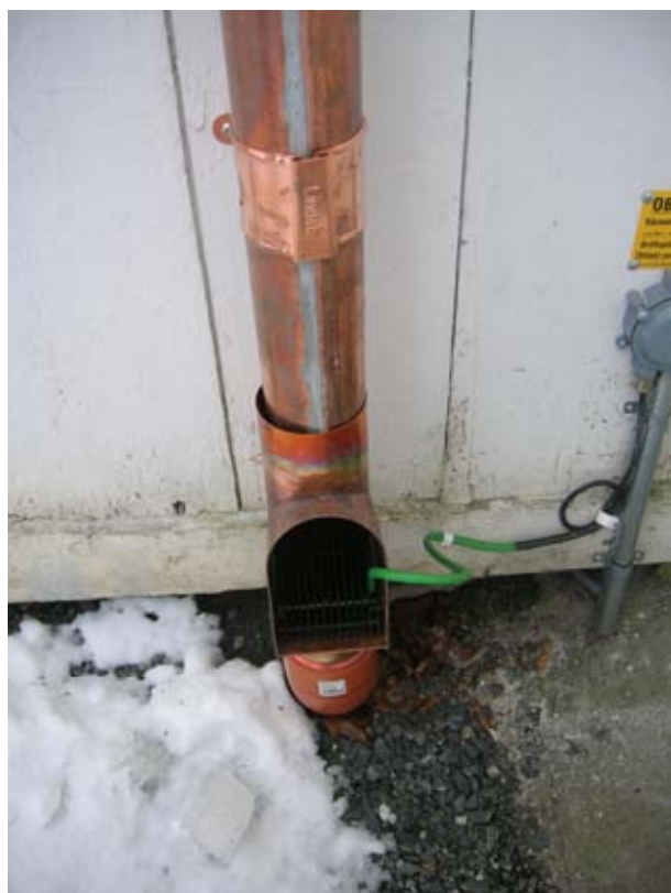
2010-11-18. Stuprör med rensträtt på sakristians västra vägg Ansluten till dränagerör mellan sakristia och korets norra vägg
