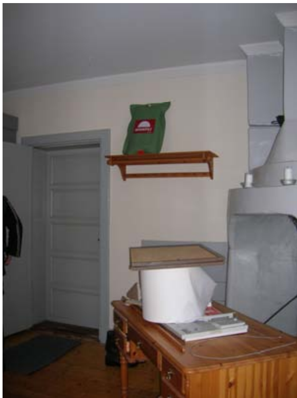
2010 11 30. Sakristians västra vägg efter målningsarbeten.
