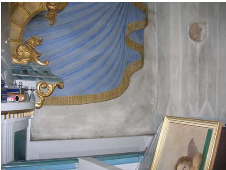
2010-08-30. Oljemålad yta, korväggens södra sida före bänköverliggarens ommålning.
