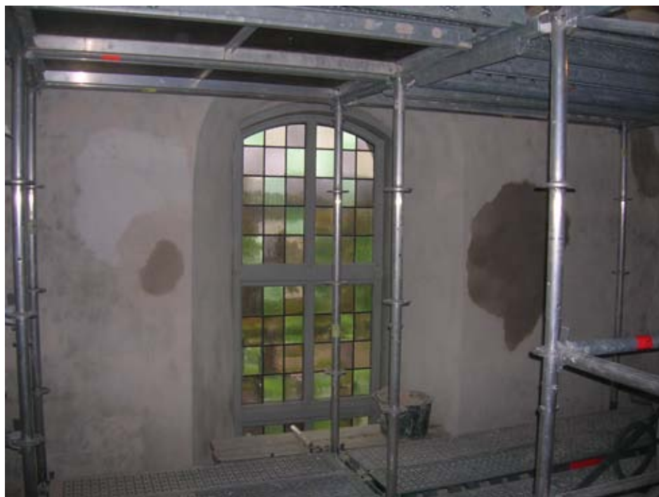
2010 09 16. Putslagningar på södra korväggen, provyta av en strykning obruten kalkfärg efter 2 dagar.
