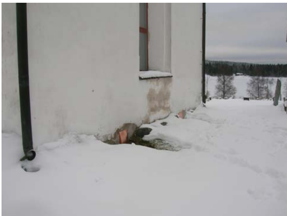
2010-11-18. Kåpor över ventiler på kyrkans västra sockel.
