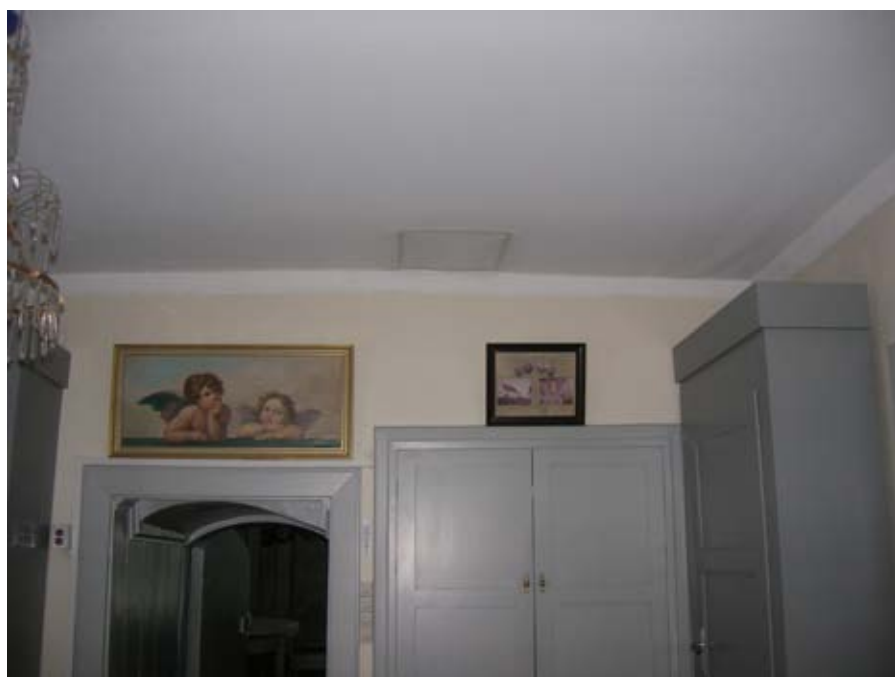
2010 04 06. Sakristians södra vägg mot kyrkorummet.
