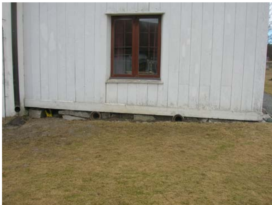
2010-04-27. Sakristians östra grund. Befintlig brunn tv.
