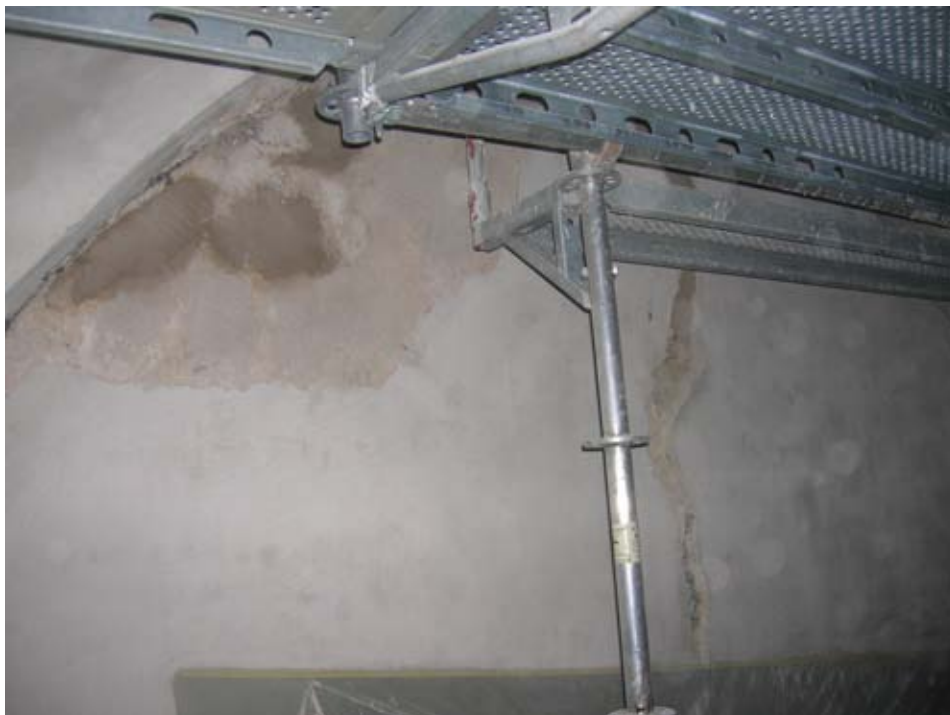
2010 09 16. Pågående spricklagningar på norra väggen ovanför läktartrappan.
