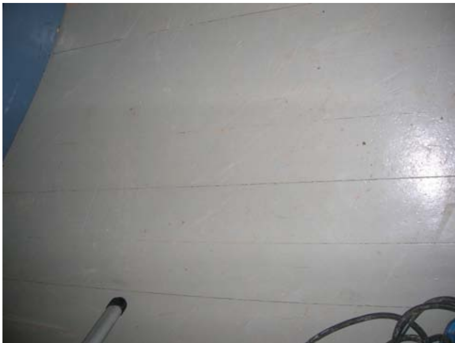
2010-06-07. Korgolvet var i gott skick efter demontering och golvbräderna behövde ej ommålas.
