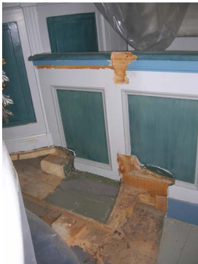
2010-04-21. Altarringen lossad på södra sidan.
