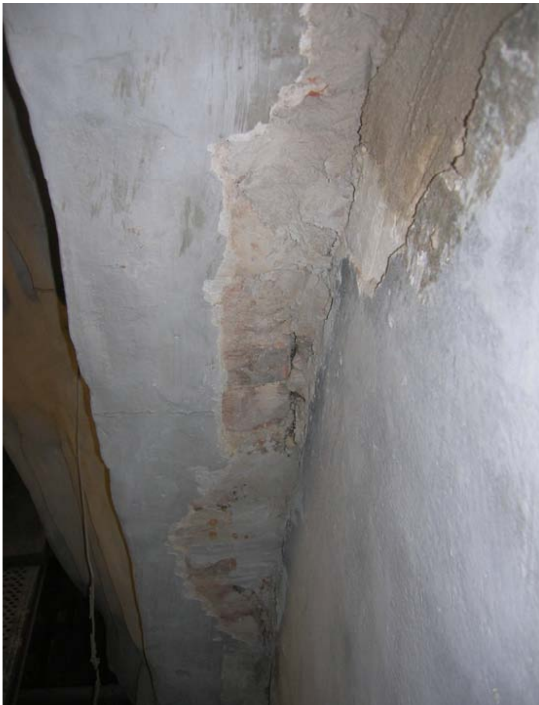
2010 09 16. Detalj, tegel i valvet, gammal puts under sentida samt grundning på natursten. Valvbåge ovanför söderfönster längst i väster.
