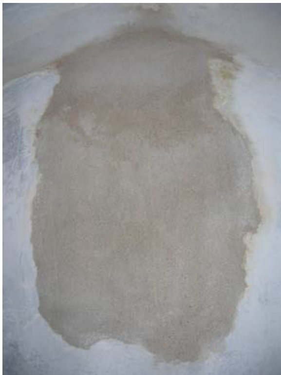
2010 09 20. Detalj, färdig putslagning ovanför söderfönster på läktaren.
