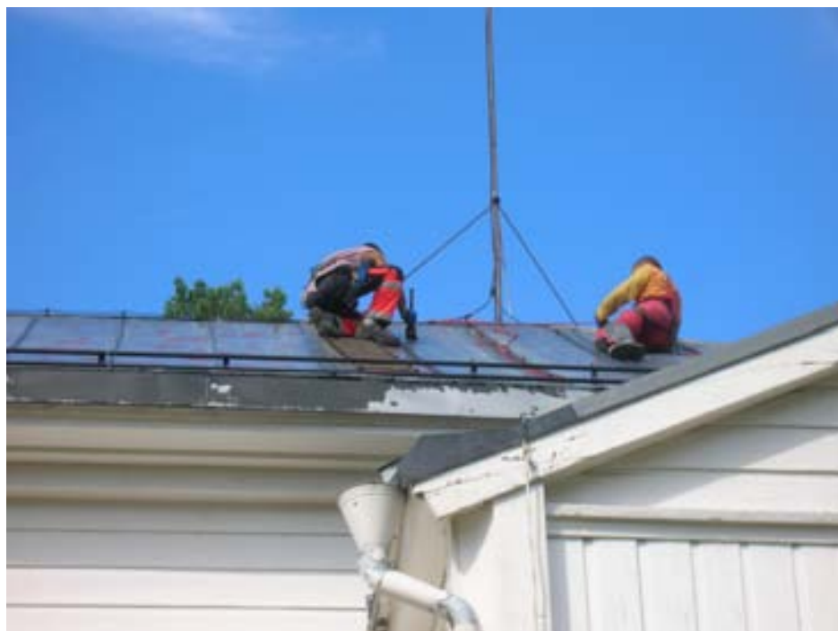
2010-07-20. Fläckgrundning av södra takfallet.
