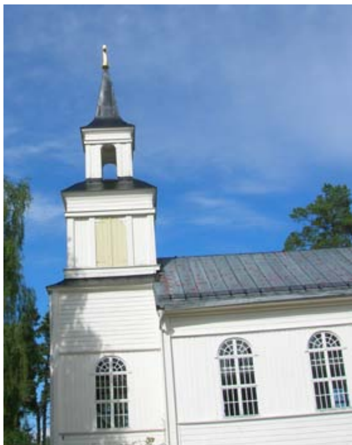
2010-07-20. Torntaket är färdigmålat med täckfärg.
