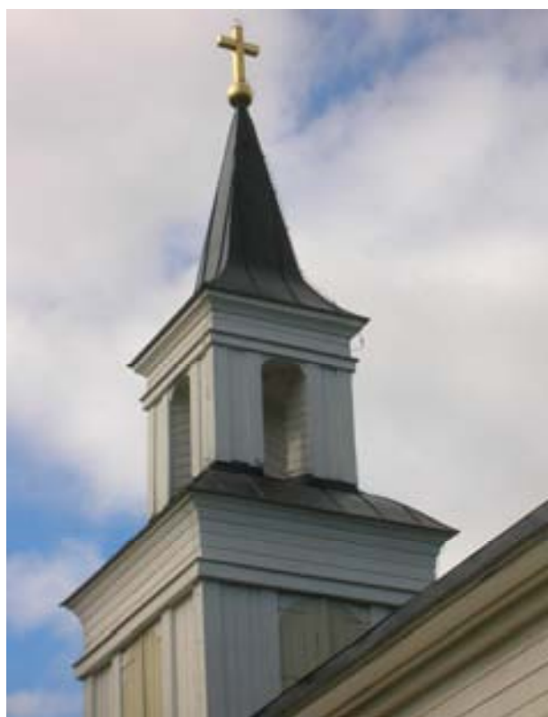
2010-08-27. Justerad åskledare på tornets SO takfall.
