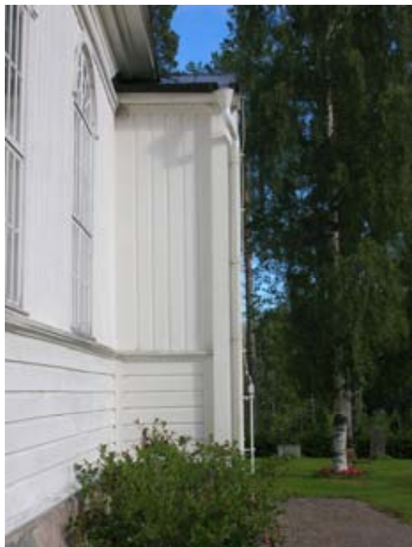
2010-07-20. Åtgärdad askledare mot söder.
