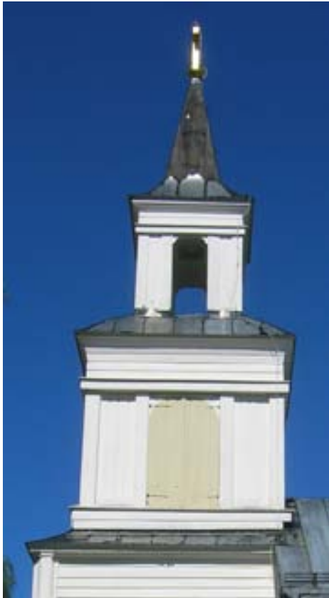
2010-07-15. Tornets södra resp. västra takfall före blästring. Åskledaren ej justerad (före etablering av skylift).
