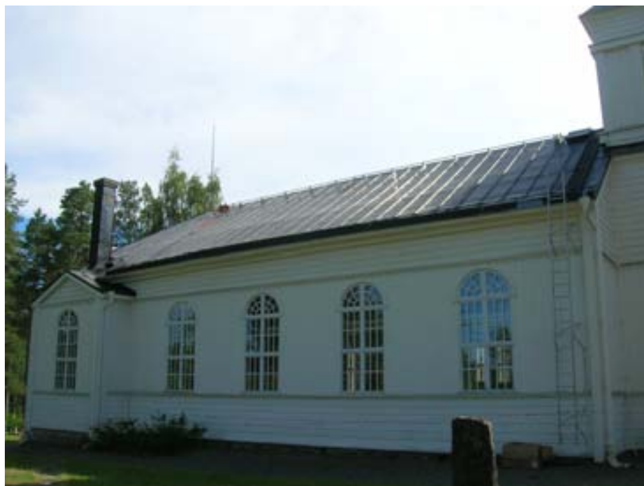
2010-07-20. Norra takfallet efter vattenblästring.
