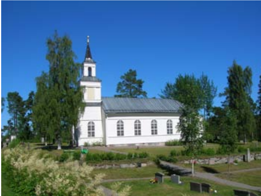
2010-07-15. Kyrkans södra takfall där Plastisolfärgen nästan har försvunnit.
