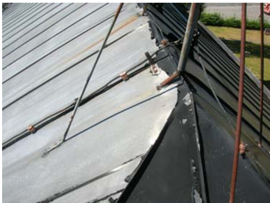
2010-07-15. Åskledarlinan och stången justerad och med nya infästningar.
