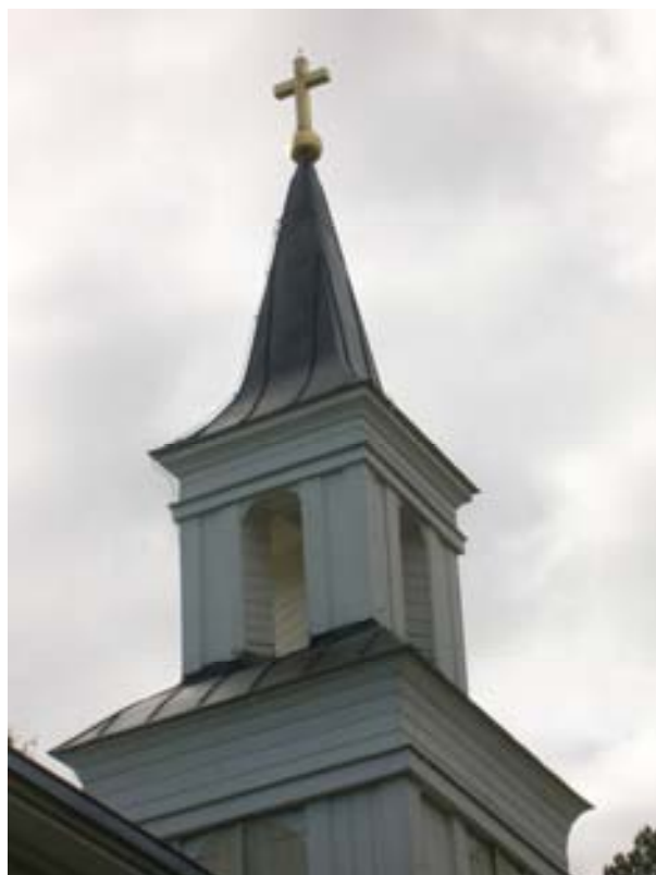
2010-08-27. NO takfallen på tornet ommålade med justerad åskledare.
