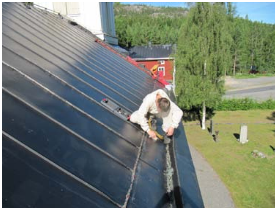
Prov på den befintliga färgens vidhäftning gjordes med glittersnittsprov före ommålning. Södra takfallet, foto: Y-Plåt.
