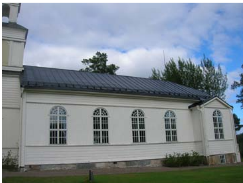
2010-08-27. Södra takfallet efter ommålning.
