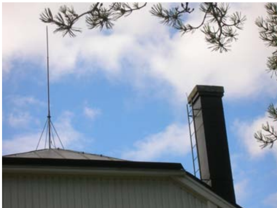
2010-08-27. Åskledarlina, stång och skorsten efter justeringar, rostskyddsbehandling och ommålning.
