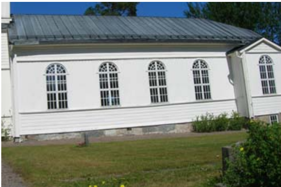
2010-07-15. Kyrkans södra takfall före ommålning. Nytt takrasskydd monterat.
