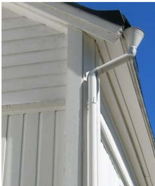
2010-07-15. Stuprör på långhusets SV resp. NV hörn före bättringsmålning.
