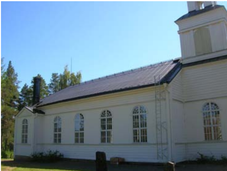
2010-07-15. Långhusets norra takfall med Plastisolfärg före blästring. Nytt nockräcke.
