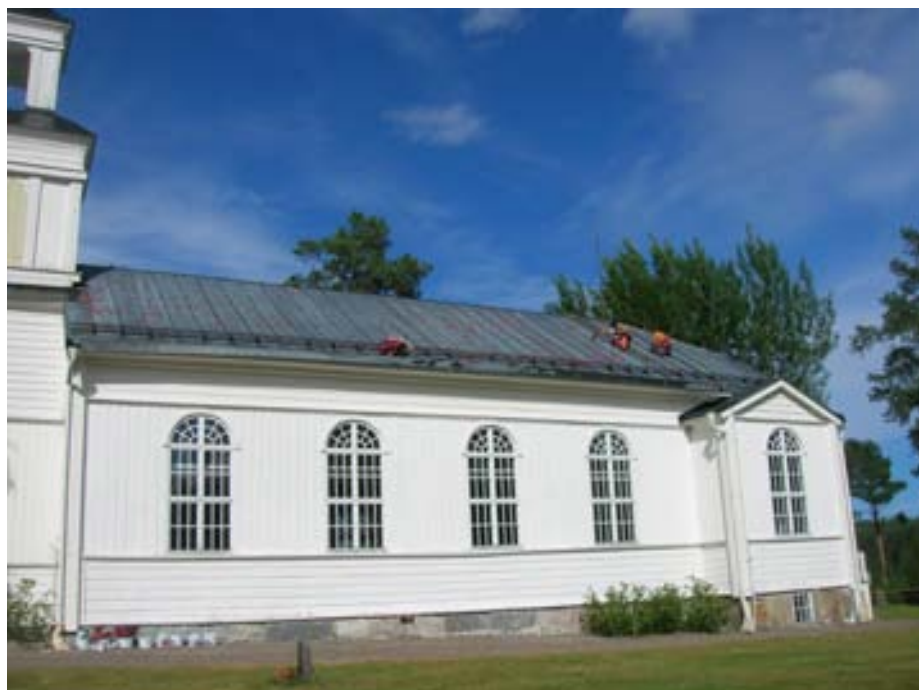
2010-07-20. Skrapning, slipning med sandpapper och fläckgrundning av det blåstrade södra takfallet.
