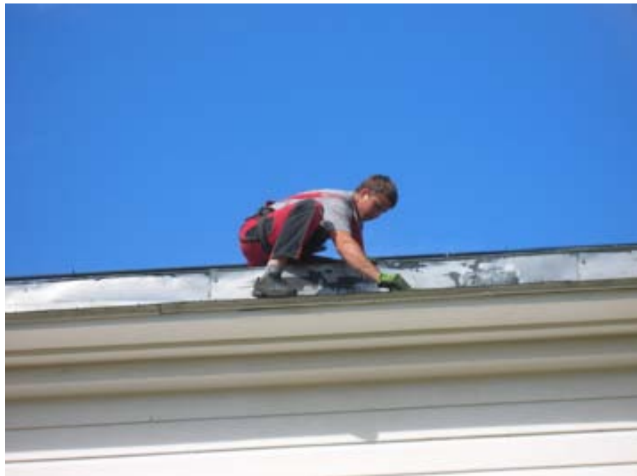
2010-07-20. Skrapning längs fotrännan, södra takfallet.
