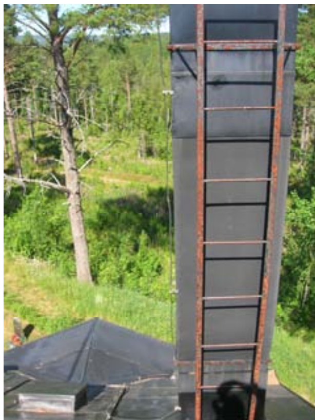
2010-07-15. Skorstensstege före rostbehandling/om målning.
