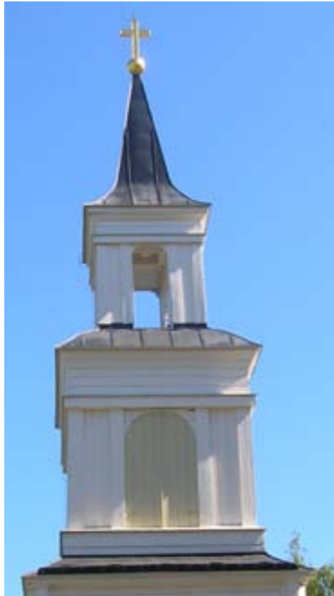
2010-07-15. Tornets södra resp. västra takfall före blästring. Åskledaren ej justerad (före etablering av skylift).
