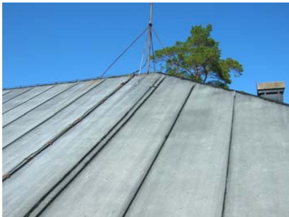
2010-07-15. Åskledarlinan justerad och infästningar har kompletterats.
