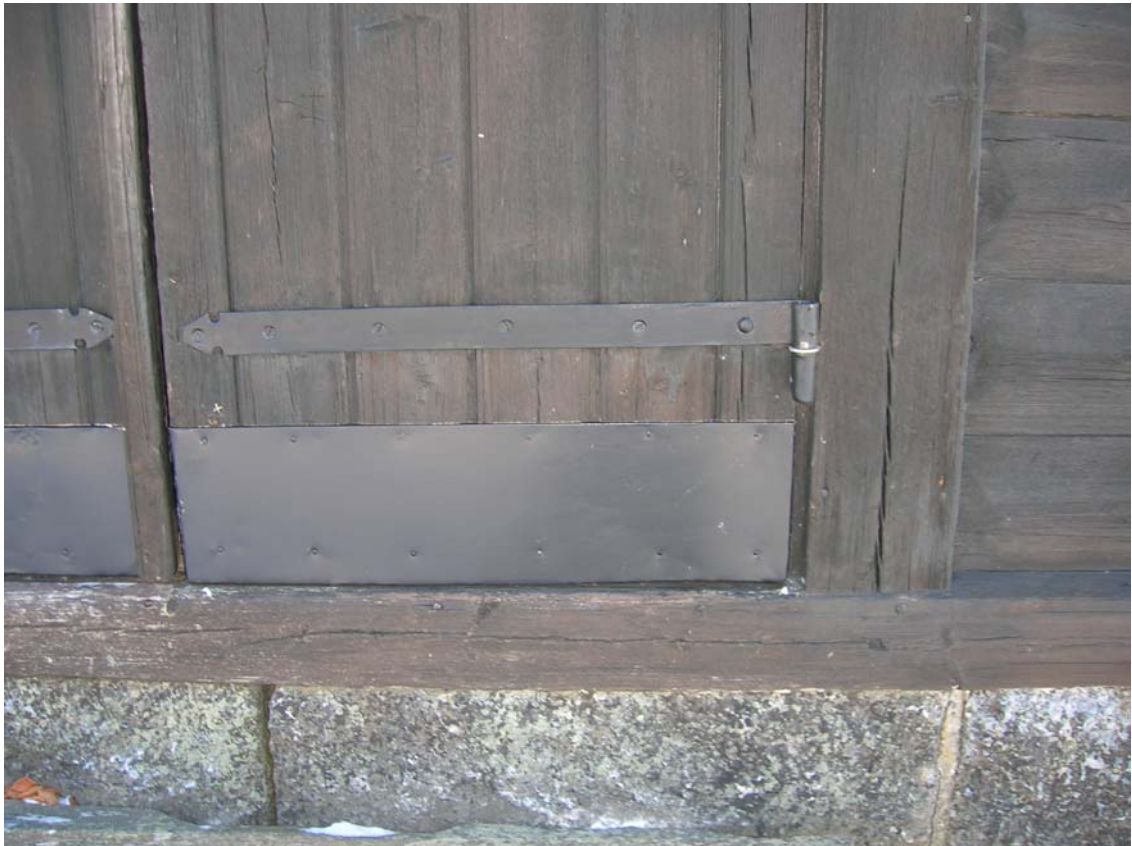
2007-10-12. Igensatt äldre dubbelport mot söder, detaljbild av panel och foder.
