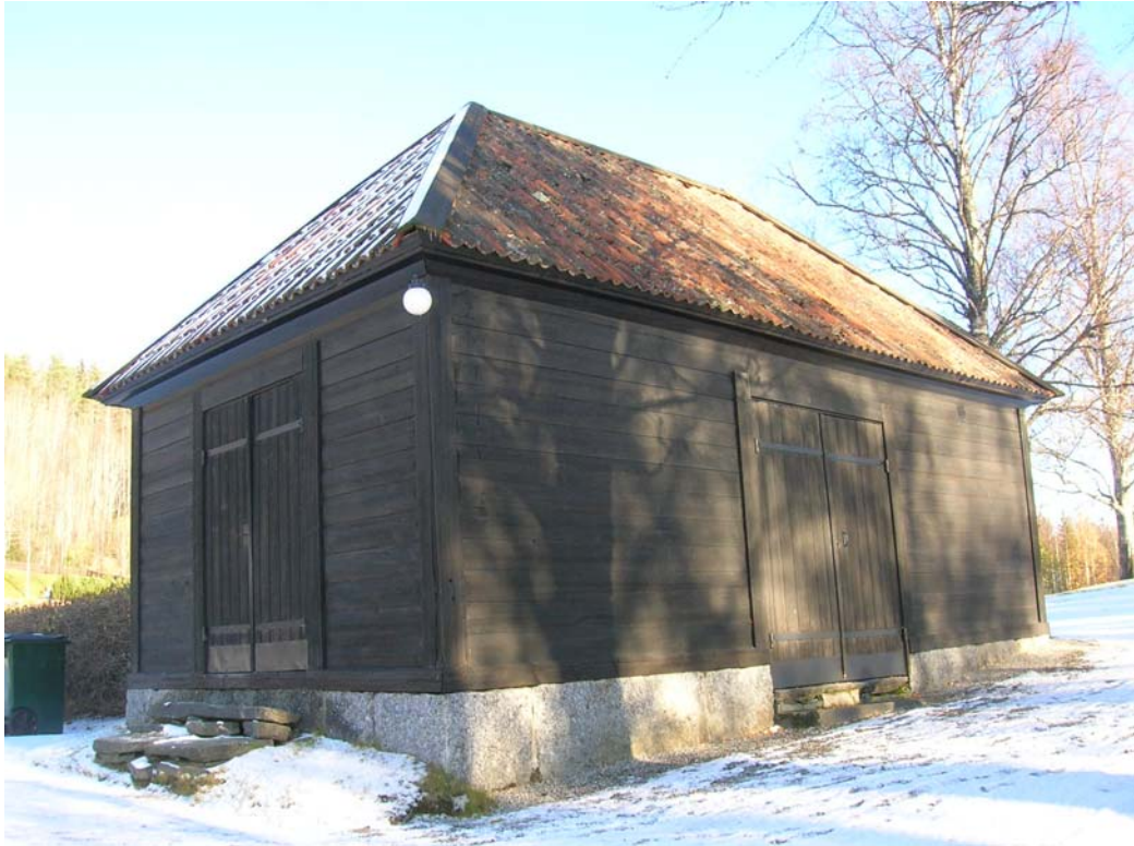
Äldre dubbelportar mot väster och söder 2008-03-19.
