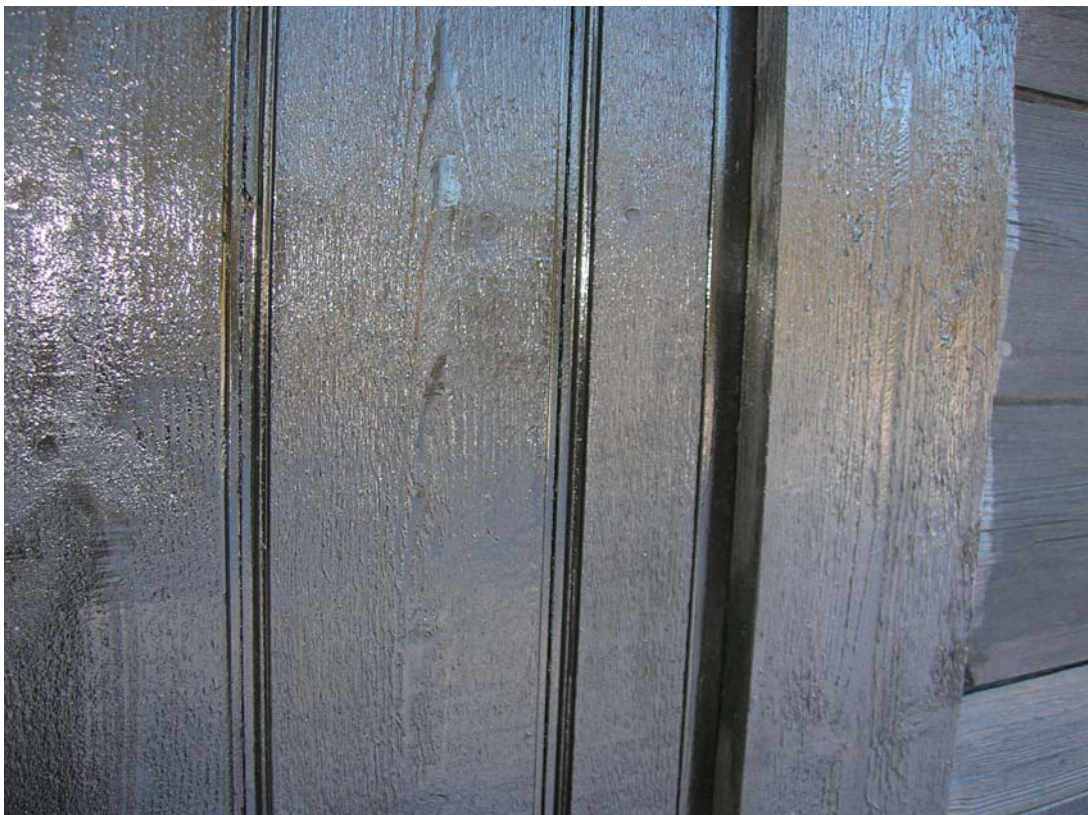
2007-10-12. Nyttillverkad dörr mot öster, detalj av dörrblad och foder.
