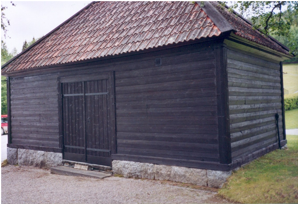
Kistboden före ombyggnaden. Foto Hjördis Ek 2004-06-30.
